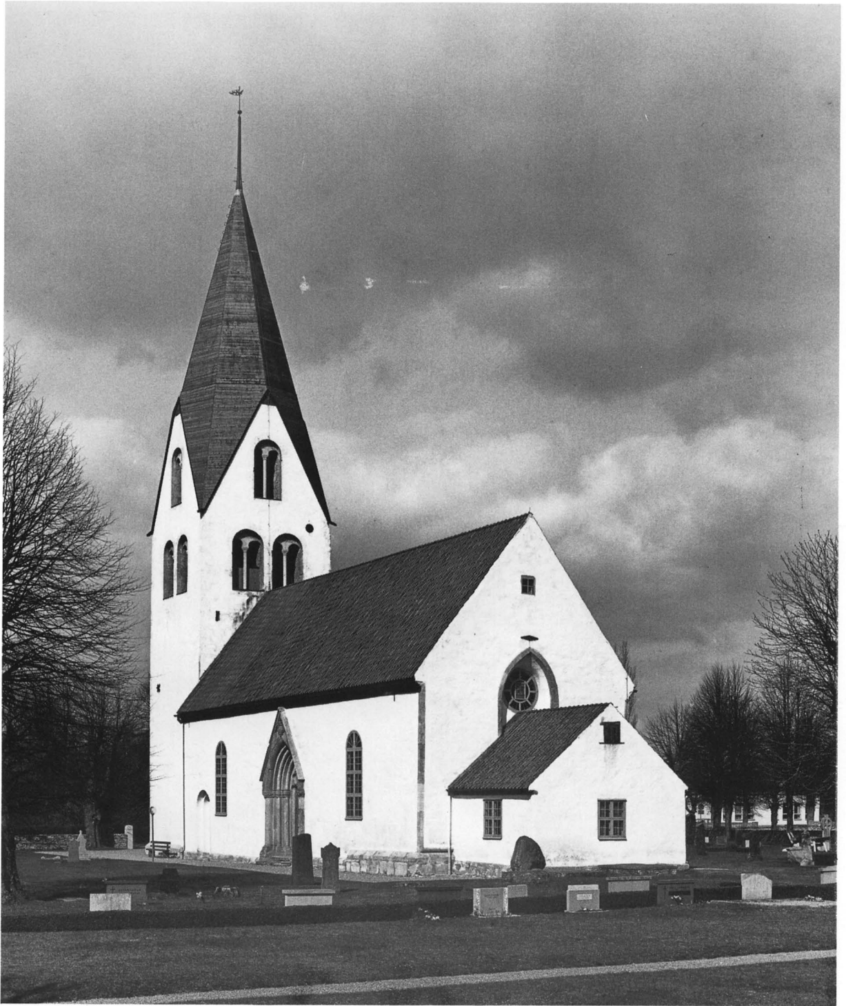
Fig 10. Kyrkan från sydost. Foto 1978.
