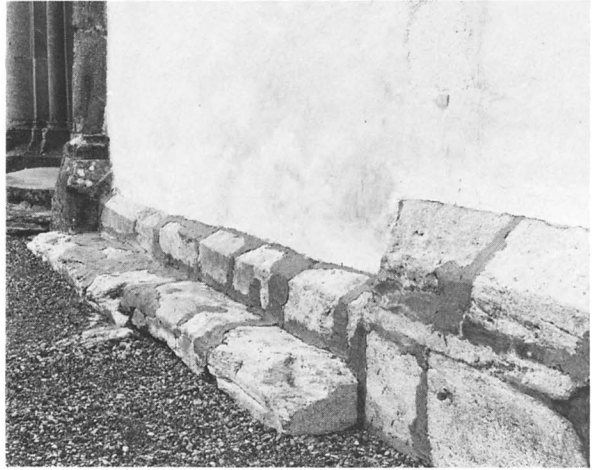
Fig 51. Del av korets södra fasad med spår efter korportalens ursprungliga placering. Märk de svagt svängda sockelstenarna, som sannolikt härrör från en absid. Foto 1976.
