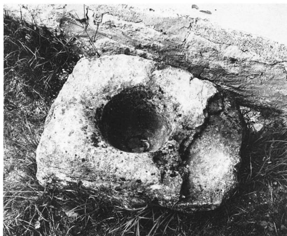
Fig 47. Bas av grå kalksten, för stock till medeltida vinschordning. Foto 1976.
