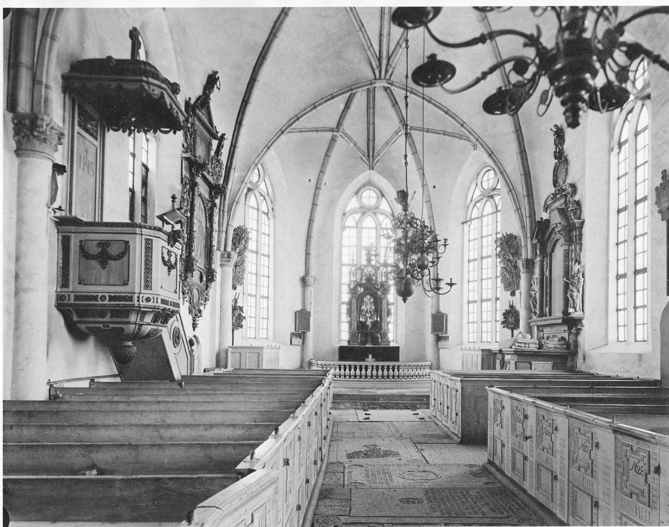
Fig 35 c. Interiör mot öster. Äldre foto, taget före 1913. Den gustavianska predikstolen, gjord av Pehr Ljung 1780, uppsatt 1780–1913, då den ursprungliga predikstolen återinsattes. Valvräbbornas målning ursprunglig, förnyad 1866, övermålad 1933. Gravstenarna i gånngen har senare flyttats fram till koret, där en del bänkar tagits bort. Foto NordM.
