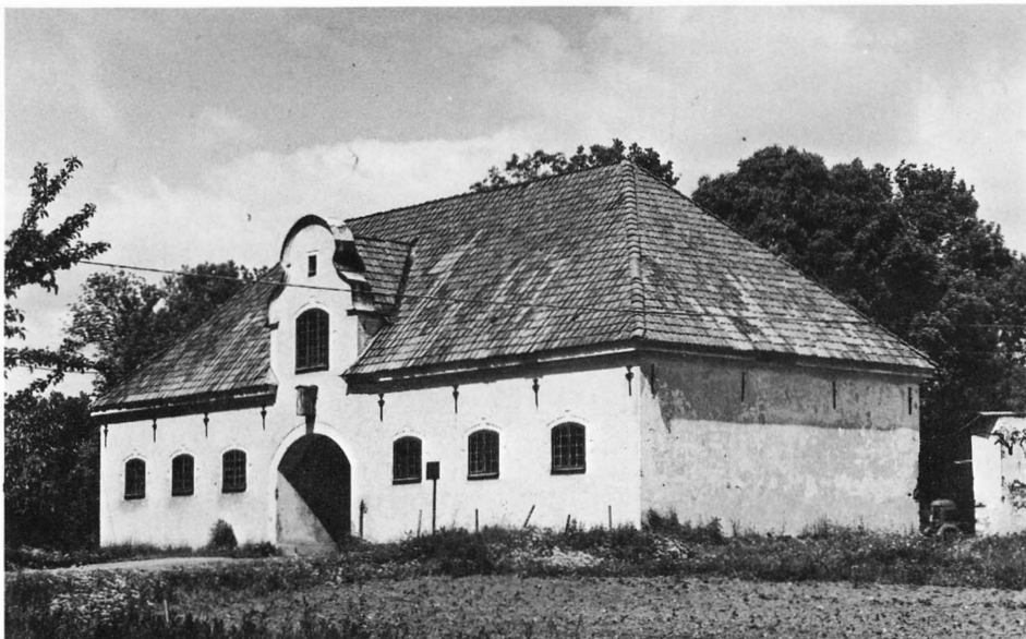
Fig 9. Förrådsbyggnad, belägen ca 200 m nordöst om Tyresö slott, under 1700-talet använd som stall (jfr fig 3 c). I denna byggnad inrymdes troligen kapellet åren 1628–1640. Foto 1978.
