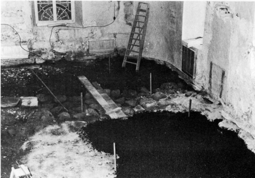
Fig 77. Grunden till medeltidskyrkans östra korvägg, frilagd i samband med restaureringen 1964. Foto Allan Johansson, Frillesås.
