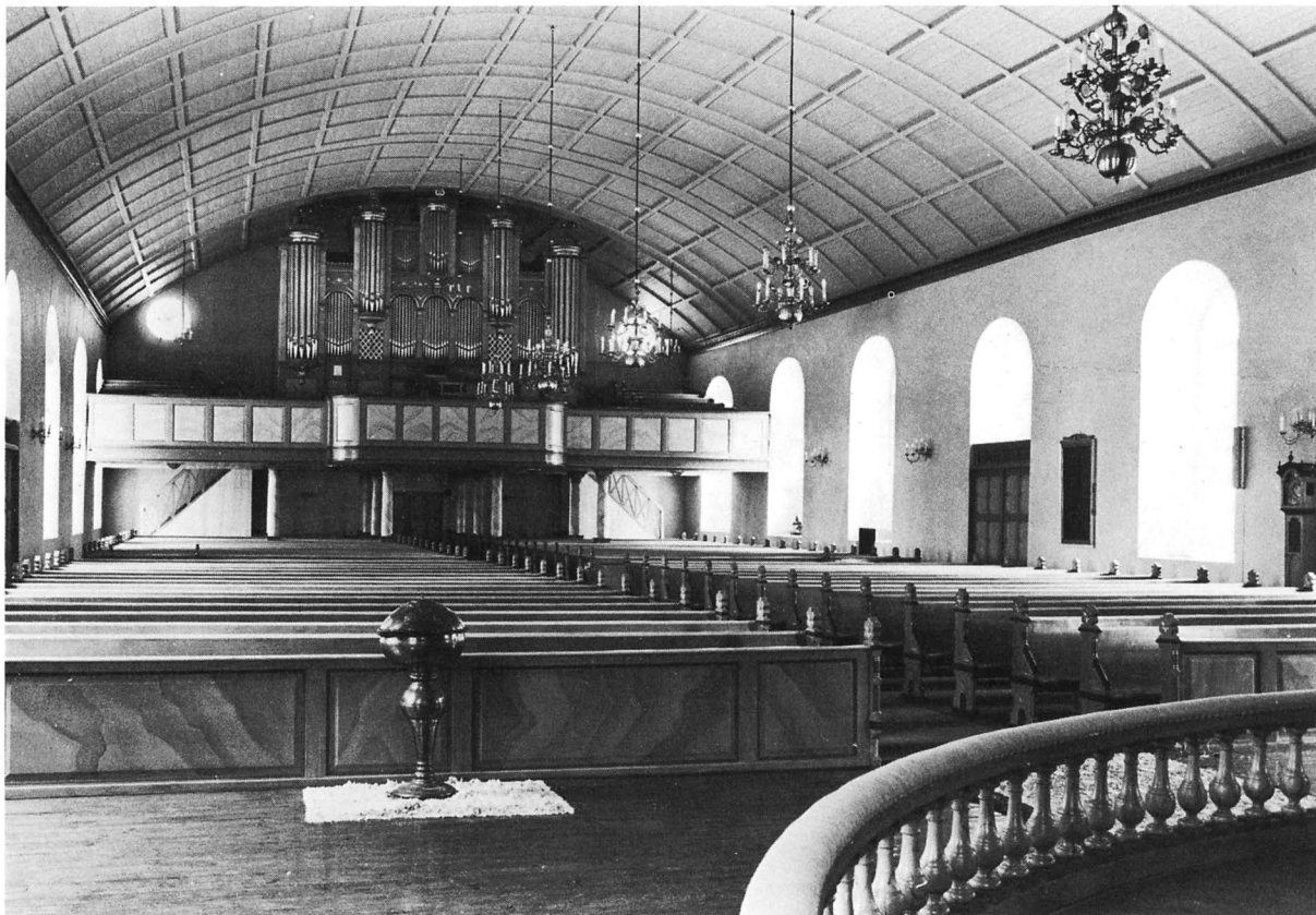
Fig 39. Interiör mot väster. Foto P Rittsel 1976.
