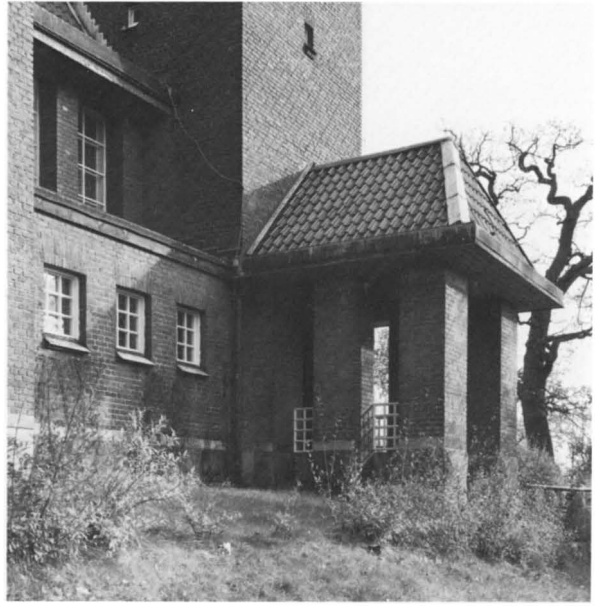
Fig 38. Sydvästra fasadens södra ingång.
