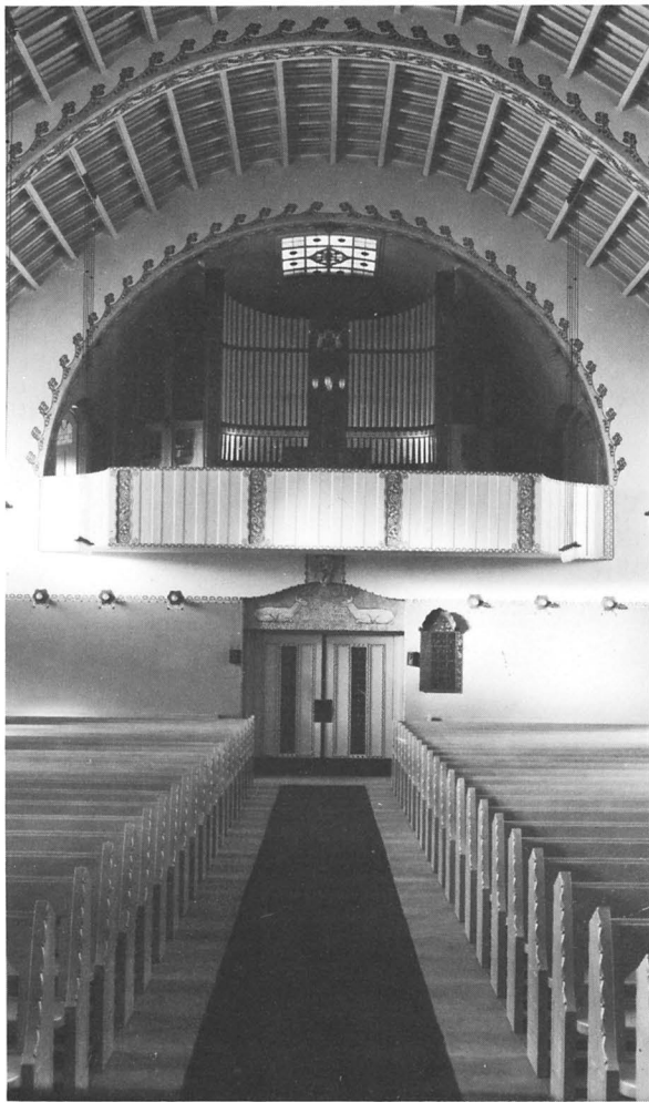
Fig 82. Interiör mot nordväst med ursprunglig orgelfasad och takfönster. Förändrad 1961. Jfr fig 42. Foto A Swinhuvud, ATA.
