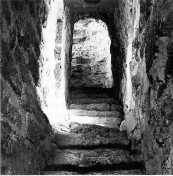
Fig 22. Nedre delen av trappa (A) i tornets norra mur sedd nedifrån. Tv ingången till första våningen. Foto S Hallgren 1978.
