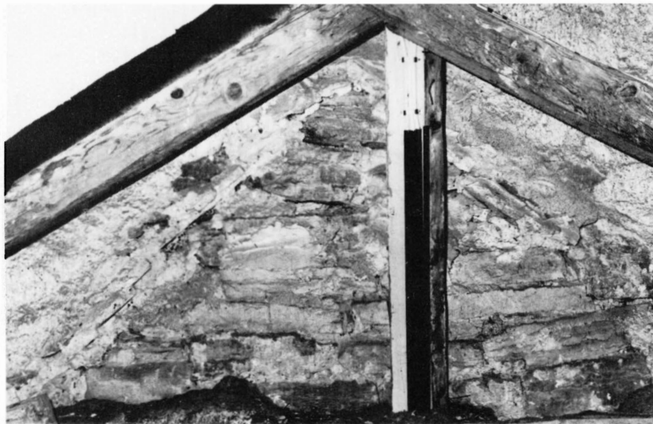
Fig 16. Det medeltida långhusets västgavel och ett stycke av västtornets östra mur synliga från det nuvarande långhusets vind (jfr fig 20 b, 32). Foto A Hyckenberg 1977
