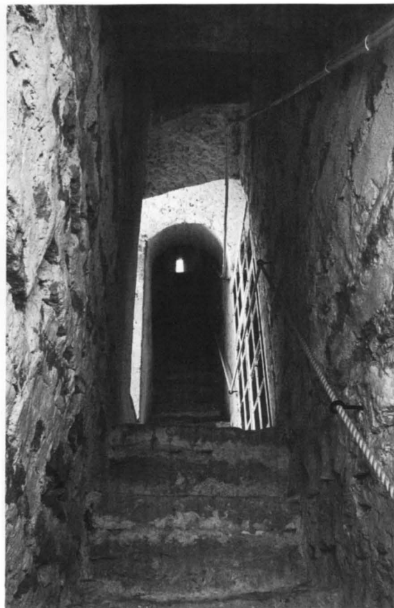
Fig 37. Trappan i tornets västra mur. Foto 1979.
