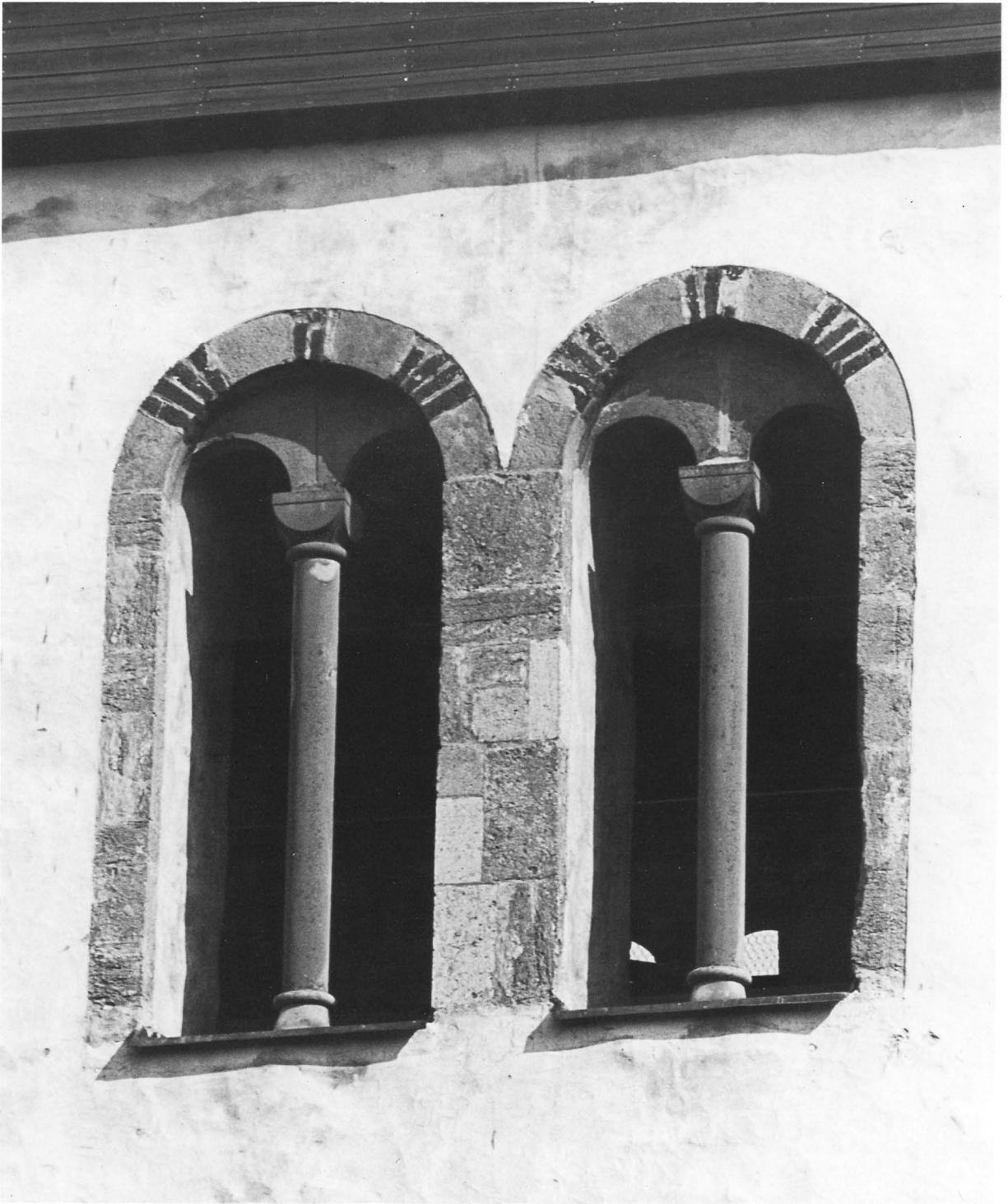
Fig 41. Ljudöppningar i tornets klockvåning. I bågarna omväxlande kalksten och tegel. Foto 1979.
