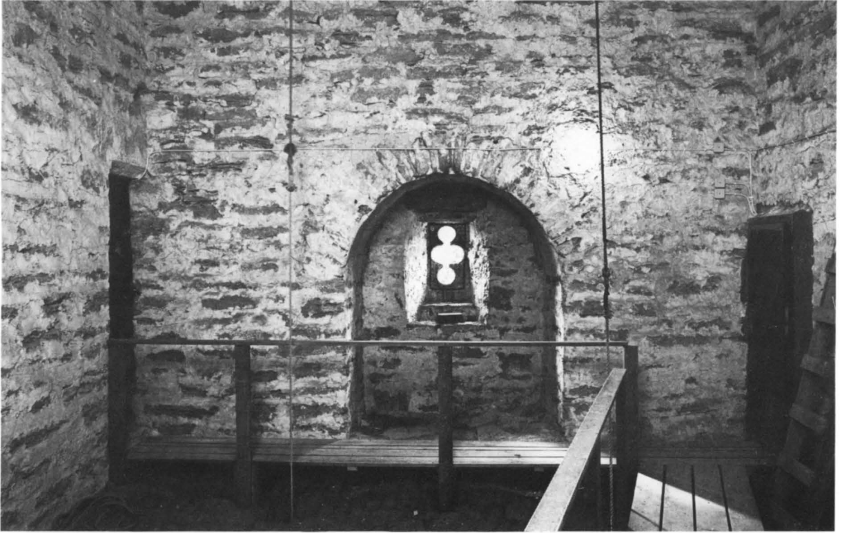
Fig 39. Tornets första övervåning mot väster. Foto 1979.
