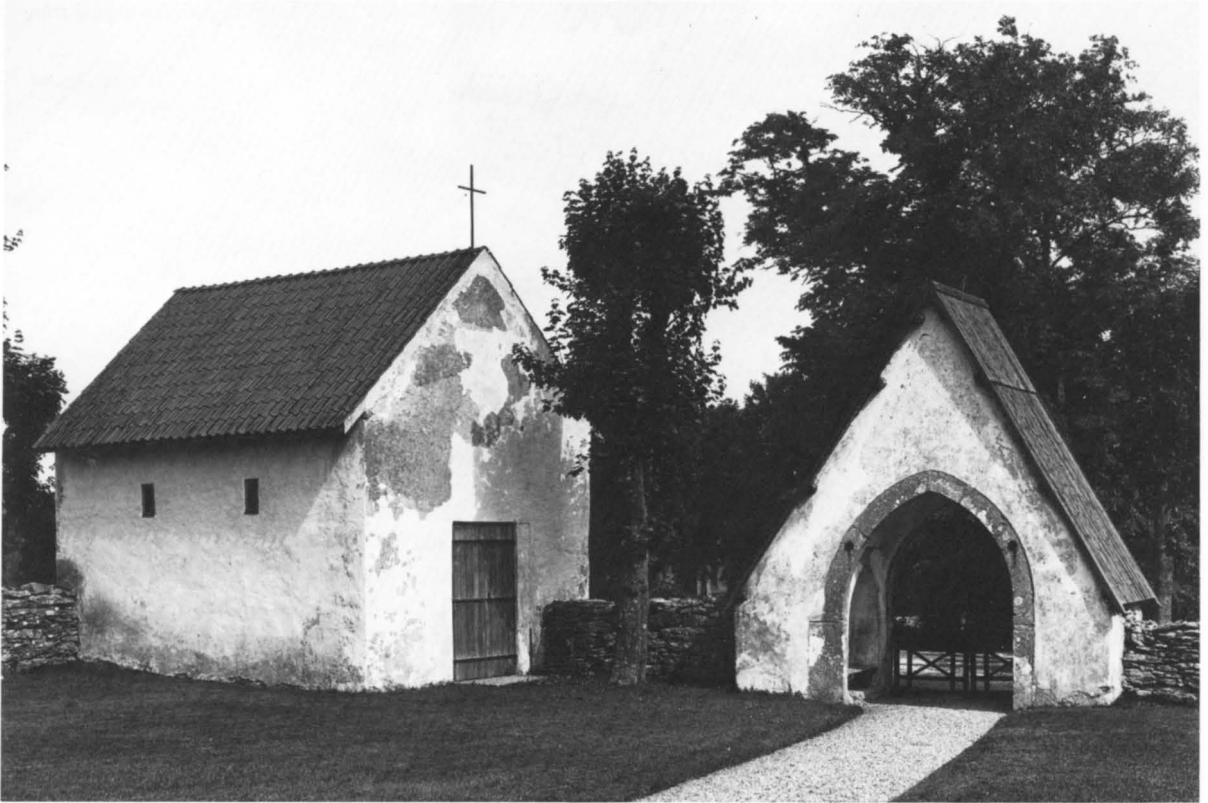
Fig 6. Magasinsbyggnad, nu bårhus, uppförd 1835 samt medeltida stiglucka. Foto 1980.
