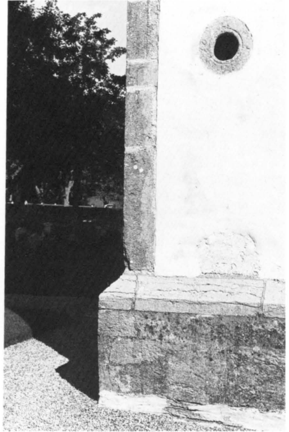
Fig 36. Tornets sydvästra hörn med ljuslugg för torntrappan. Foto 1979.
