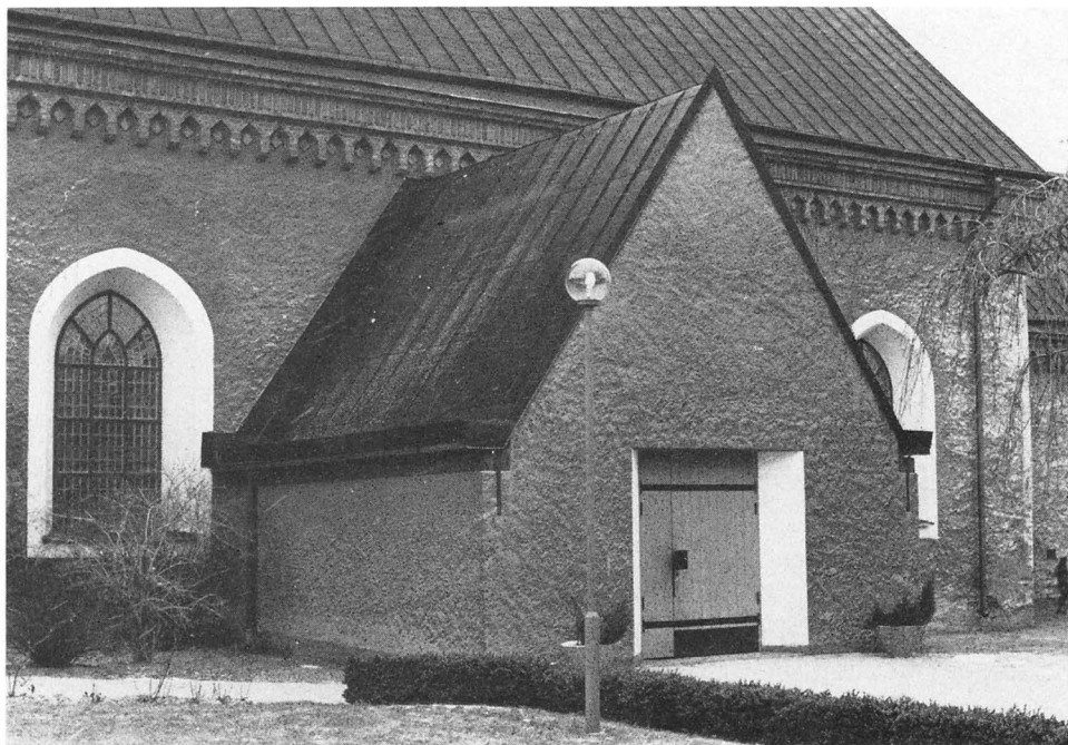
Fig 23. Vapenhuset, uppfört vid kyrkans restaurering 1966–67. Foto R Bennett 1981.
