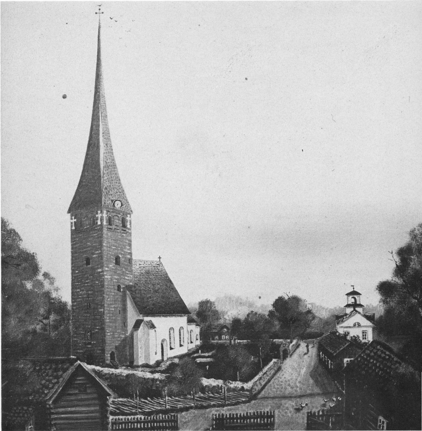
Fig 28. Kyrkan sedd från sydväst vid mitten av 1800-talet. Foto i Torshälla hembygdsmuseum efter äldre målning. Lägg märke till den murade kyrkogårdsporten som ännu står kvar på södra sidan.
