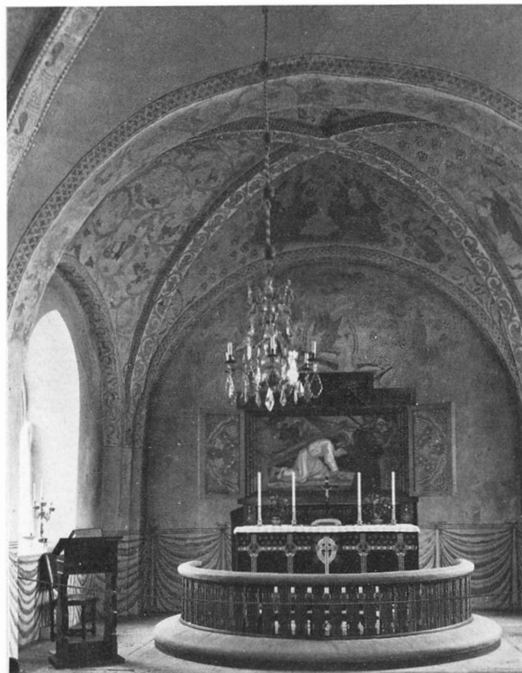
Fig 34. Interiör av koret efter restaureringen 1911–12. Foto I Anderson 1945.
