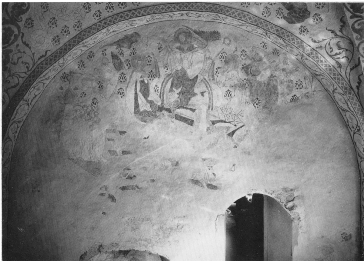
Fig 42. Yttersta domen. Skadad kalkmålning på korets östra vägg. Foto S Wallin 1911.
