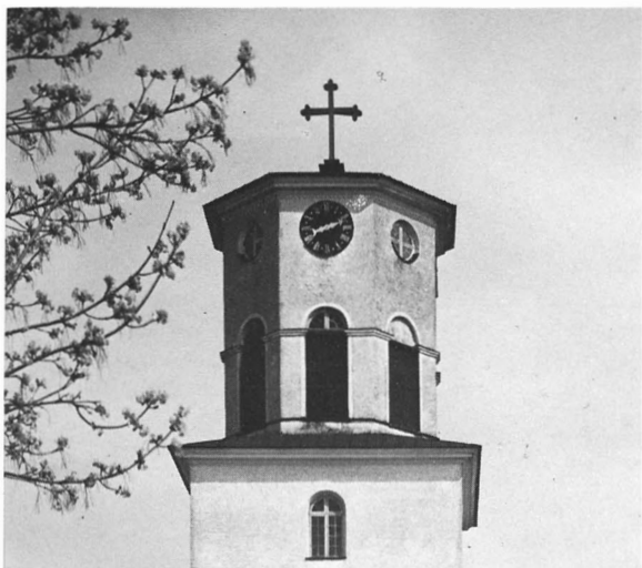
Fig 77. Lanterninen före restaureringen 1937. Gul med svarta luckor och även svarta blinderingar. Foto A Edle 1931.
