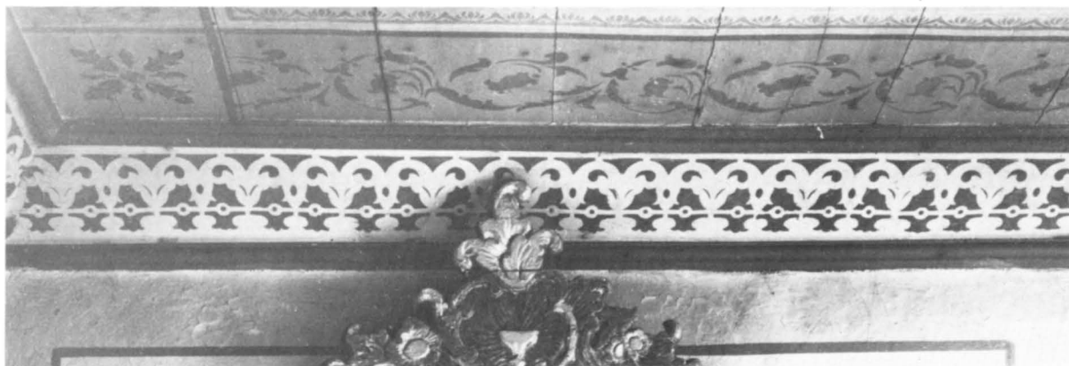
Fig 85–86. Schablonerad dekorationsmålning från 1895 i grått samt flera nyanser brunt, dels i långhuset (fig 85), dels i sakristian (fig 86), utförd av målaremästare Lindeman. Foto A Edle 1931.
