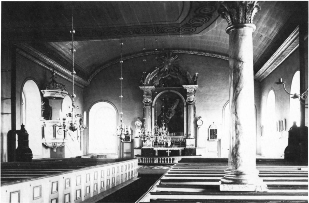
Fig 84. Interiör mot öster före restaureringen 1937. Foto A Edle 1931.
