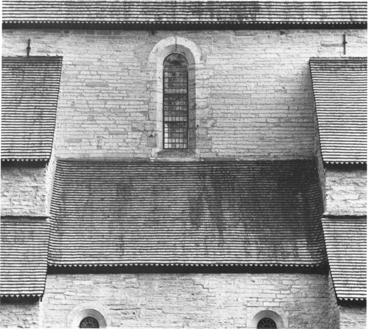
Fig 25. Parti av norra långhusmuren. Foto 1978.
