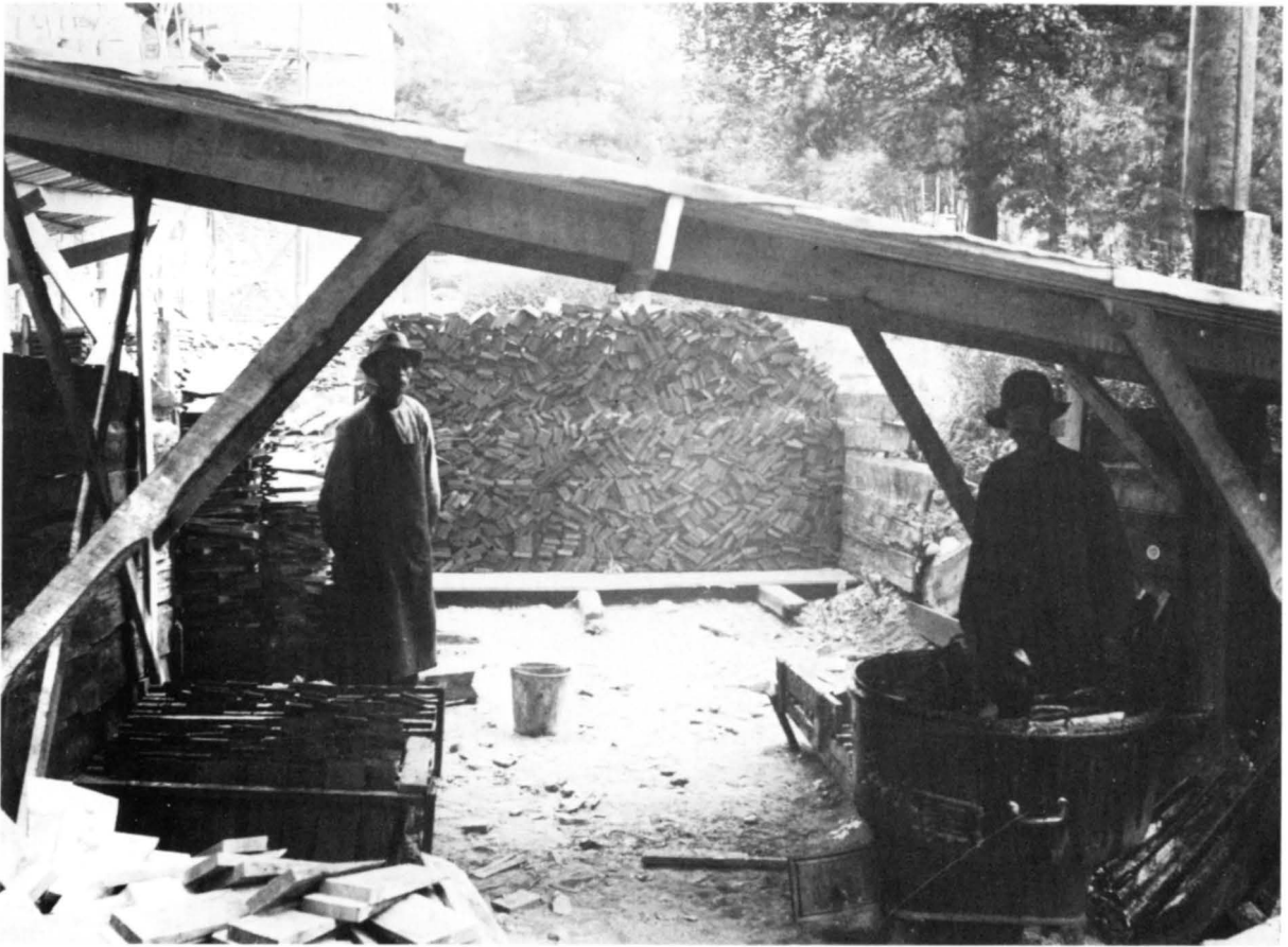
Fig 98. Tjärbokning av takspån i samband med Curmans restaurering. Foto A Forssén 1920, ATA.
