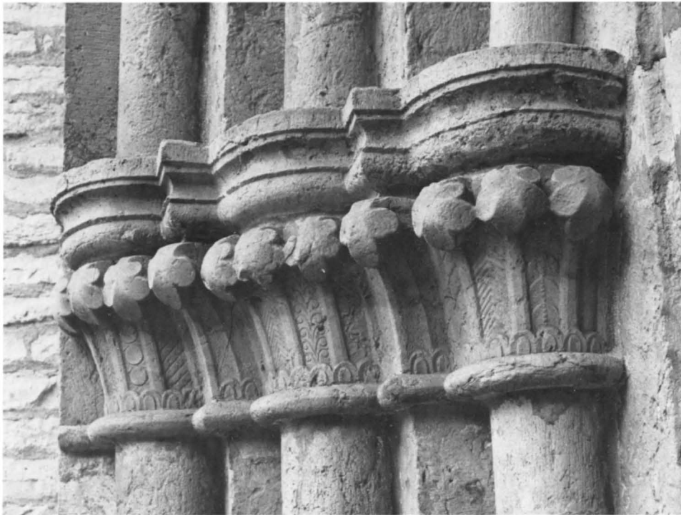
Fig 30–31. Klosterkyrkans västportal. På ömse sidor ses spåren av att portalen sekundärt infogats på sin nuvarande plats i västgavelns mitt. Uptill till höger ses nedre delen av den stora trefönstergruppens ursprungliga yttre omfattning. Ovan detalj av västportalens norra kapitälband. Foto 1981.
