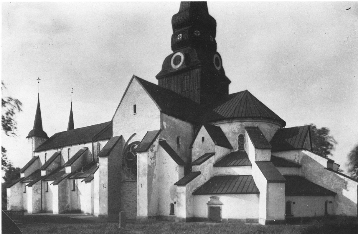
Fig 95 b. Sydfasaden innan putsen avlägsnats och murverket frilagts. Foto A Forssén 1920. ATA.
