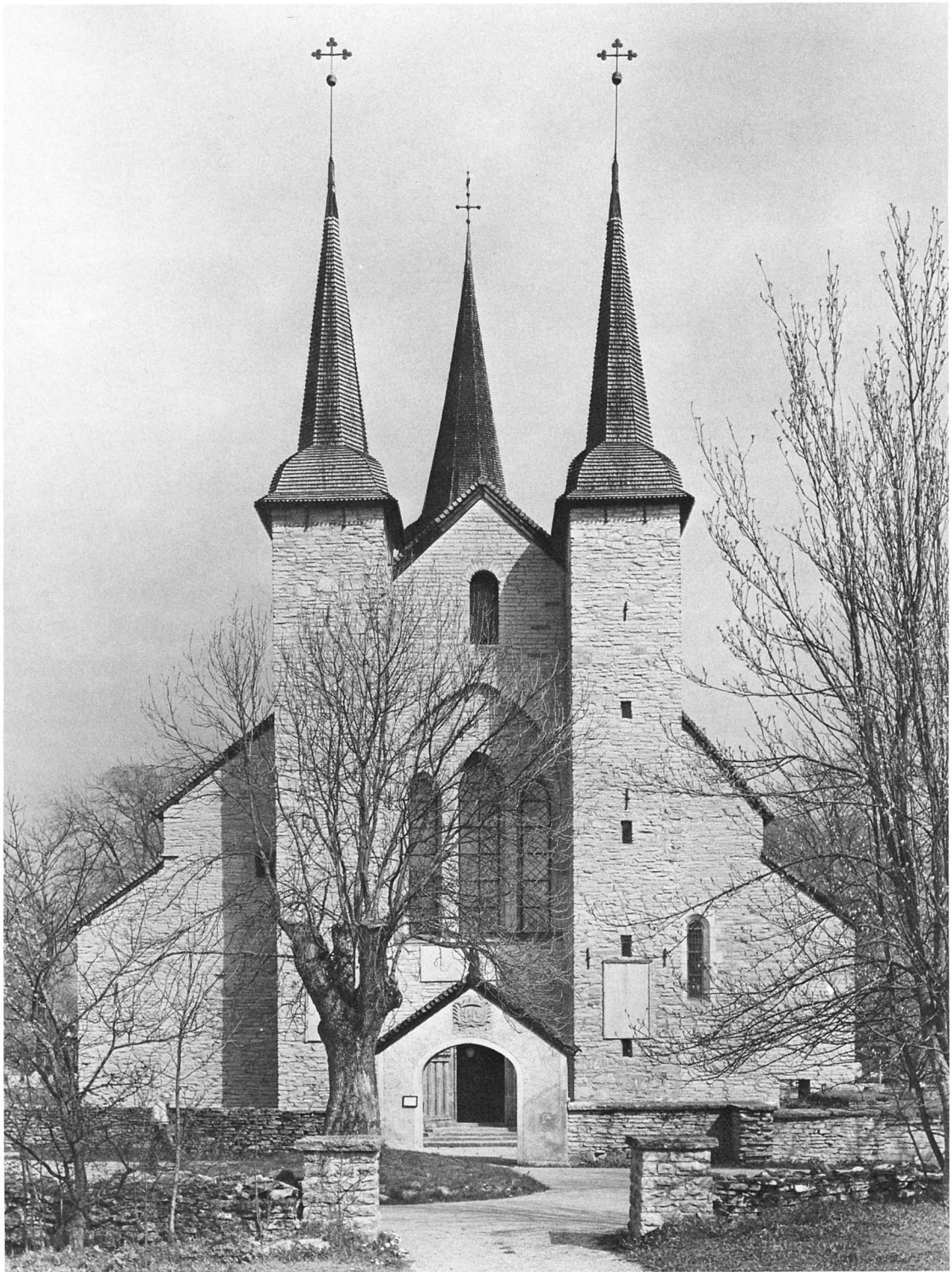
Fig 14. Västfasaden med västra kyrkogårdsporten. Foto 1978.
