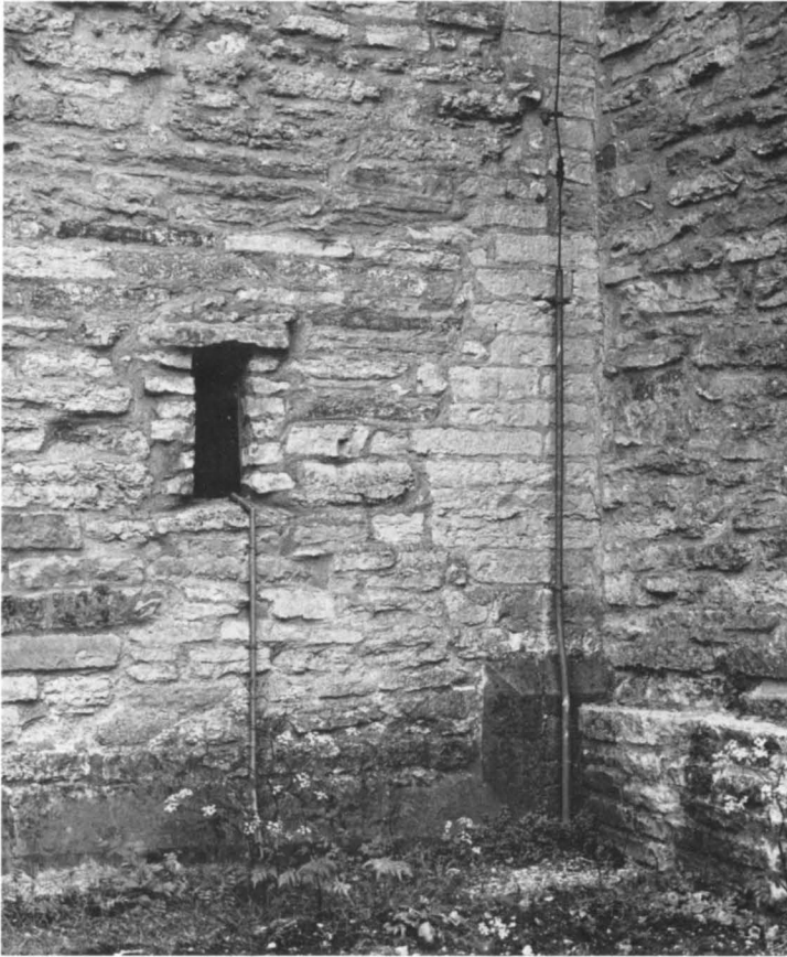
Fig 35. Långhusets nordvästra hörn med mur-skarv och sockelsprång. Foto 1978.
