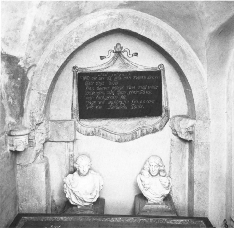
Fig 33. Resterna av munkarnas ingång i södra sidoskeppets östligaste travé. Bilden visar sydsidan som nu ingår i Magnus Gabriel De la Gardies gravkor. Foto 1981.
