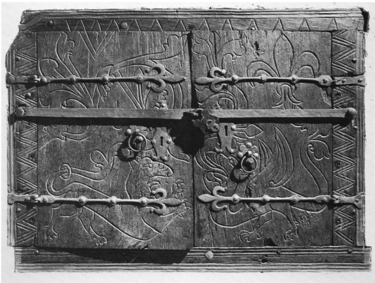
Fig 43. Väggsåp i absidens södra mur med ekdörrar med skuren dekor och järnbeslag. 1200-talets andra fjärdedel. Foto 1982.
