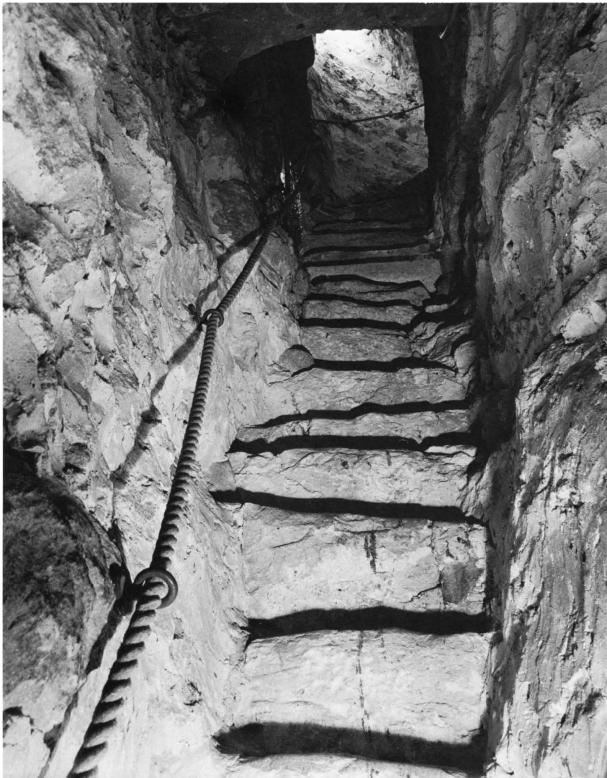
Fig 30. Trappan i tornets södra mur. Foto 1982.
