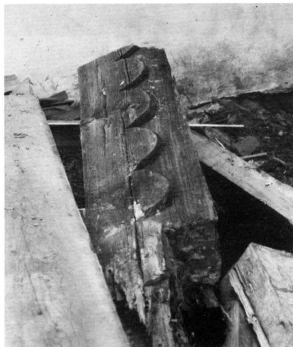
Fig 217. Fragment av syll med snidad dekor i form av bågar. Från långhusets nordöstra hörn. Foto H Wiegertz 1979. Läns-museet, Linköping.
