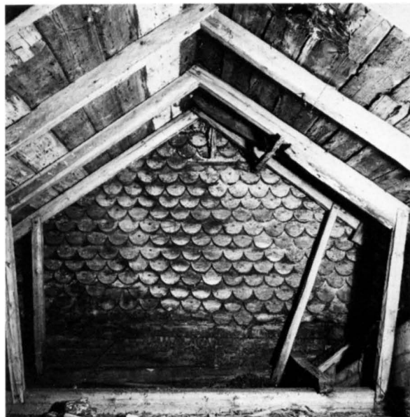
Fig 193. Korets norra vägg med panel av nedtill profilerade ekbräder. Sett från sakristians vind. Foto I Anderson 1948, ATA.
