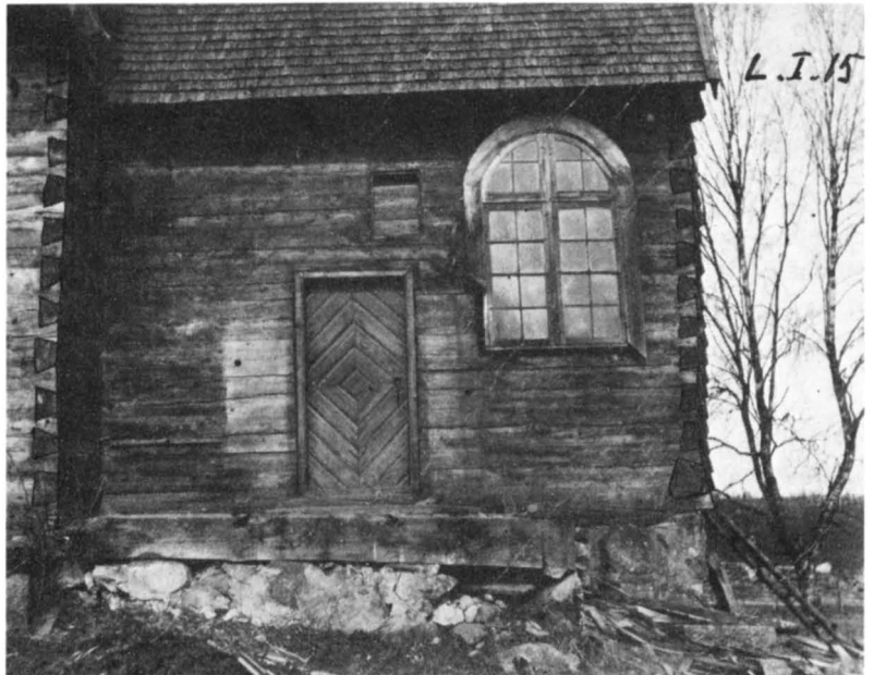
Fig 163. Korets sydfasad med synlig, här markerad, laxknutning och igensatt fönster. Foto 1902. Jönköpings läns museum.
