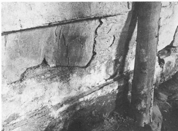
Fig. 29. Avtryck i den nuvarande kyrkans norra långhusmur av den äldre, timrade byggnaden. Foto J E Anderbjörk 1943, ATA.
