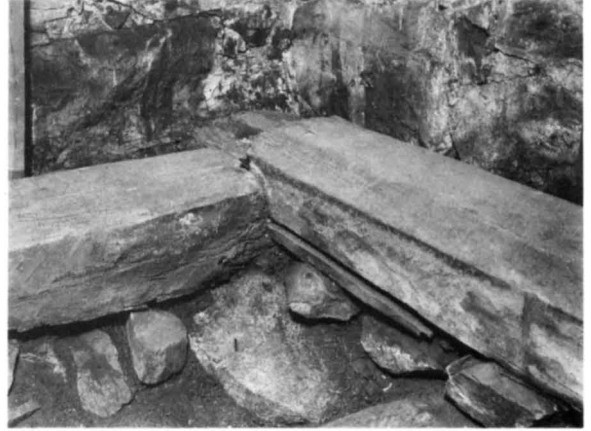
Fig 35. Syllarna i orubbat läge i långhusets sydvästra hörn. Foto J E Anderbjörk 1943, ATA.
