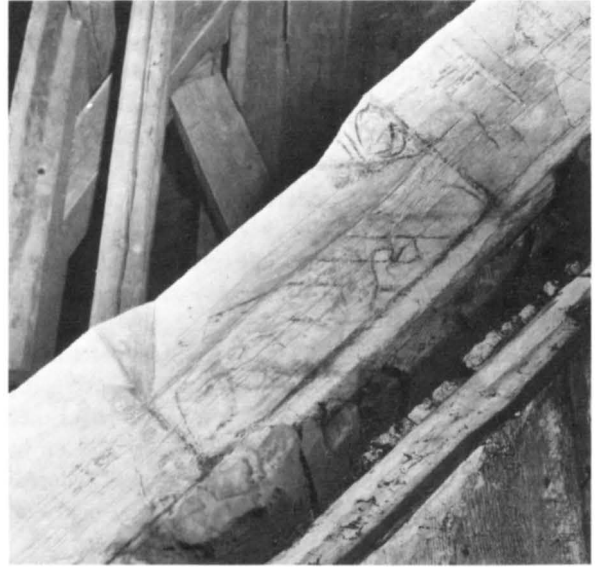
Fig 120–21. Hakarps kyrka. Sekundärt använda väggbjälkar i nuvarande kyrkans takstol med bevarad laxknut respektive nederdel av fönstersmyg. Foto S Hallgren 1974.
