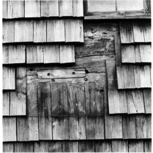
Fig 18. Södra korväggens hagioskop, sett utifrån med sin sekundära igensättning sedan väggens spåntäckning avlägsnats. Foto S. Hallgren 1972. ATA.
