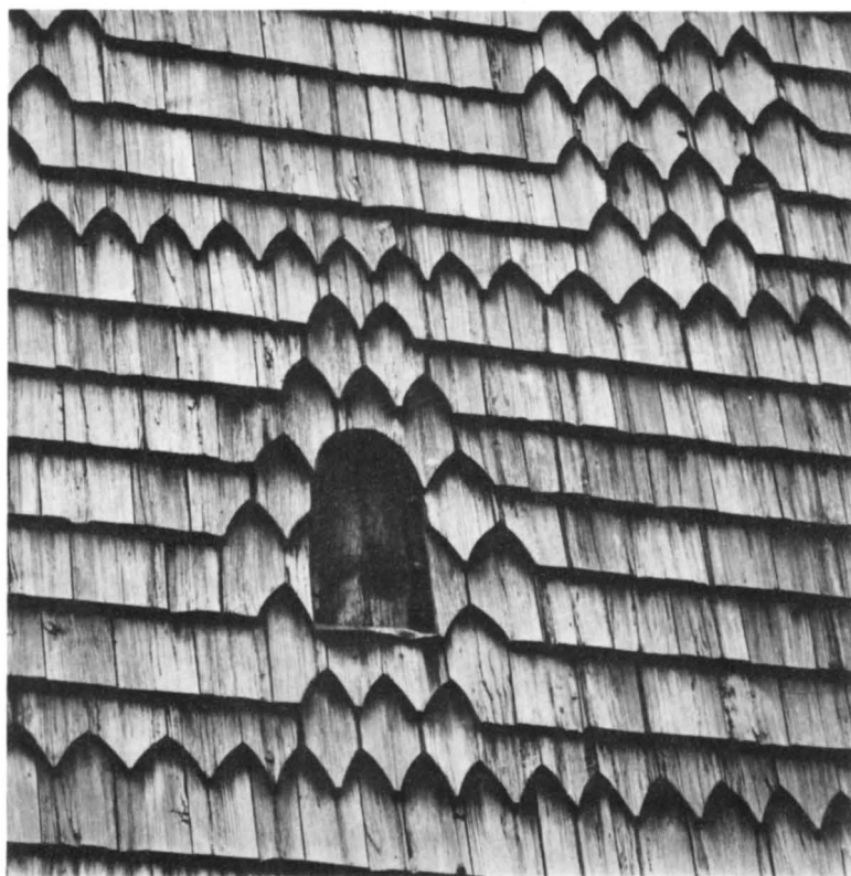
Fig 14. Detalj av korets östra gavelröste med ursprungligt fönster. Foto S Hallgren 1972. ATA.
