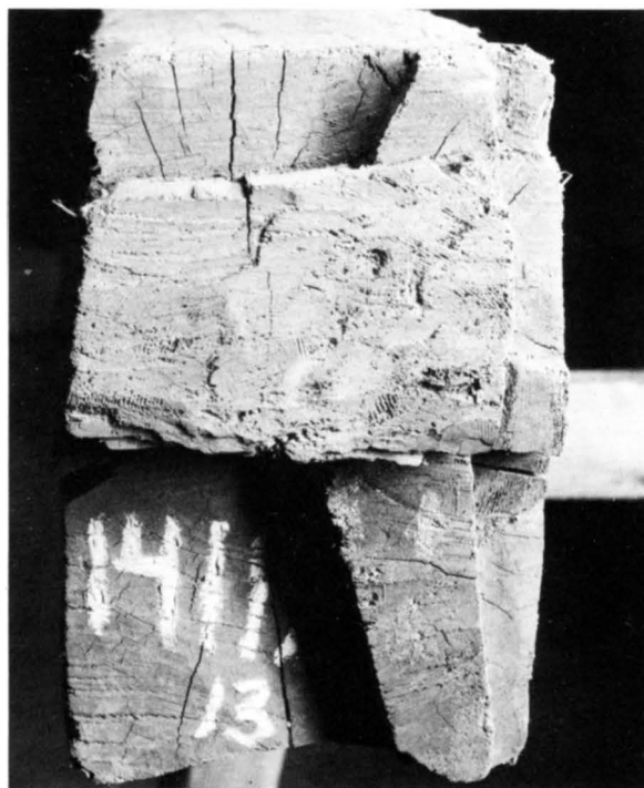
Fig 110. Väggbjälke med knuthuggning. SHM. Foto ATA. Wall beam with timbering.
