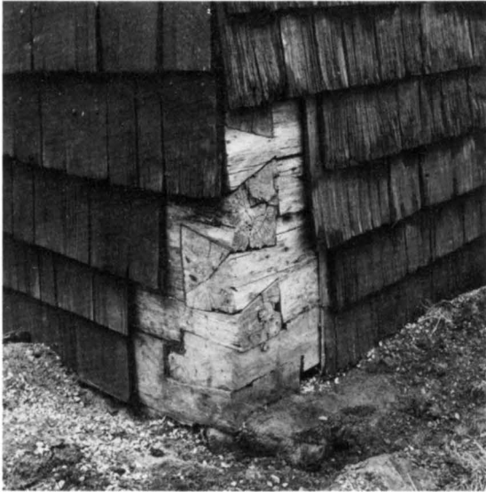
Fig 9. Detalj av långhusets nordvästra hörn med sk laxknutning. Foto S Hallgren 1972. ATA.
