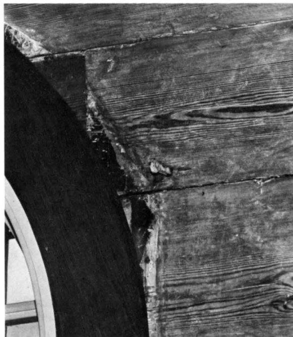
Fig 230. Spår av äldre fönsteröppningar i väggytan vid långhusets östra fönster. Jfr fig 213 f. Foto A Hyckenberg 1977.
