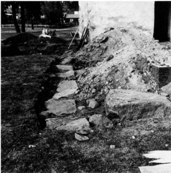
Fig 47. De vid undersökningen frilagda grundstenarna till triumfbågsväggen. Foto A Liepe 1973, ATA.
