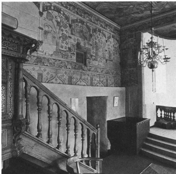
Fig 140. Norra korväggen med ursprungligt fönster. Målningarna från ca 1500. Foto S Hallgren 1974.
