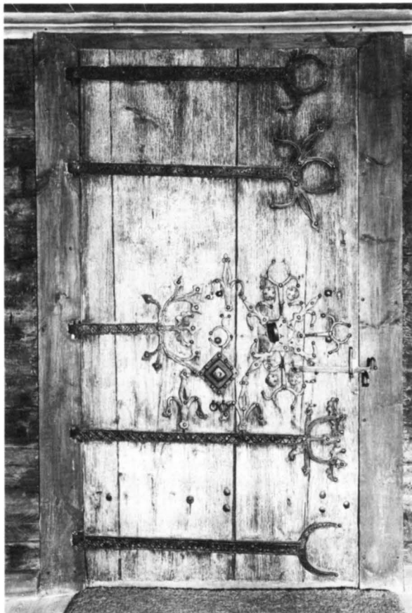
Fig 227. Långhusets västingång med medeltida, järnbeslagen dörr. Ursprungligen placerad i sydingången. Jfr fig 235 a-c. Foto A Hyckenberg 1977.
