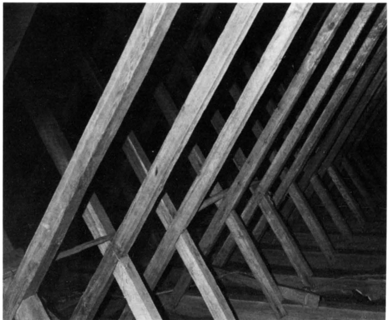
Fig 219. Detalj av långhusets dubbelkryssade takstol. Foto A Hyckenberg 1977.
