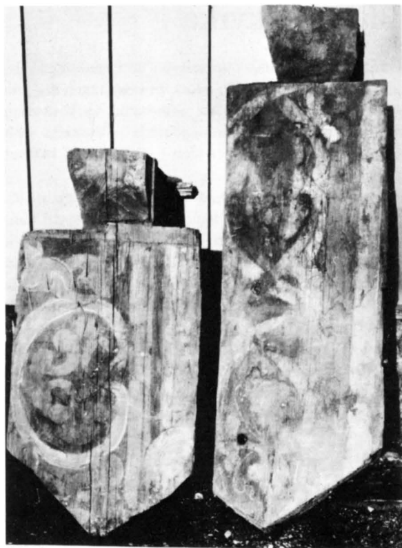
Fig 80. Fragment av knuthuggna väggbjälkar med medeltida målning. Foto P Boberg 1928, ATA.
