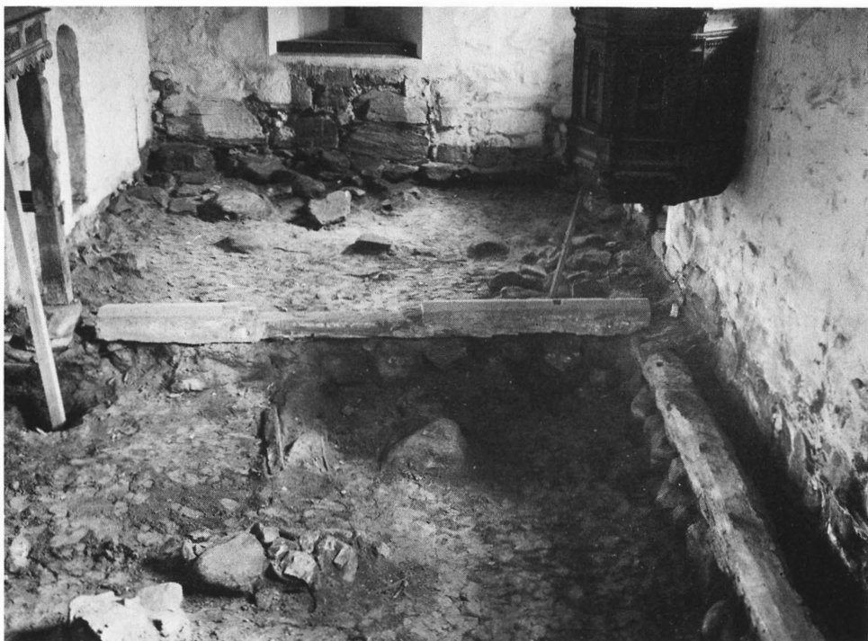
Fig 28. Södra och östra syllarna med frilagd sten- grund. Foto J E Ander- björk 1943, ATA.
