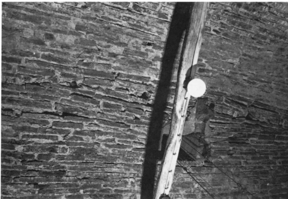
Fig 54. Fyra ursprungliga samt ett sekundärt löphål för klocklinor i andra våningens valvhjessa. Foto H Schulze 1980.
