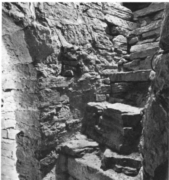
Fig 61. Trappan H mellan tornets andra och tredje våning. T v skymtar cellen J och i murverket upp till är kvaderrits bevarad. Foto R Hintze 1980.
