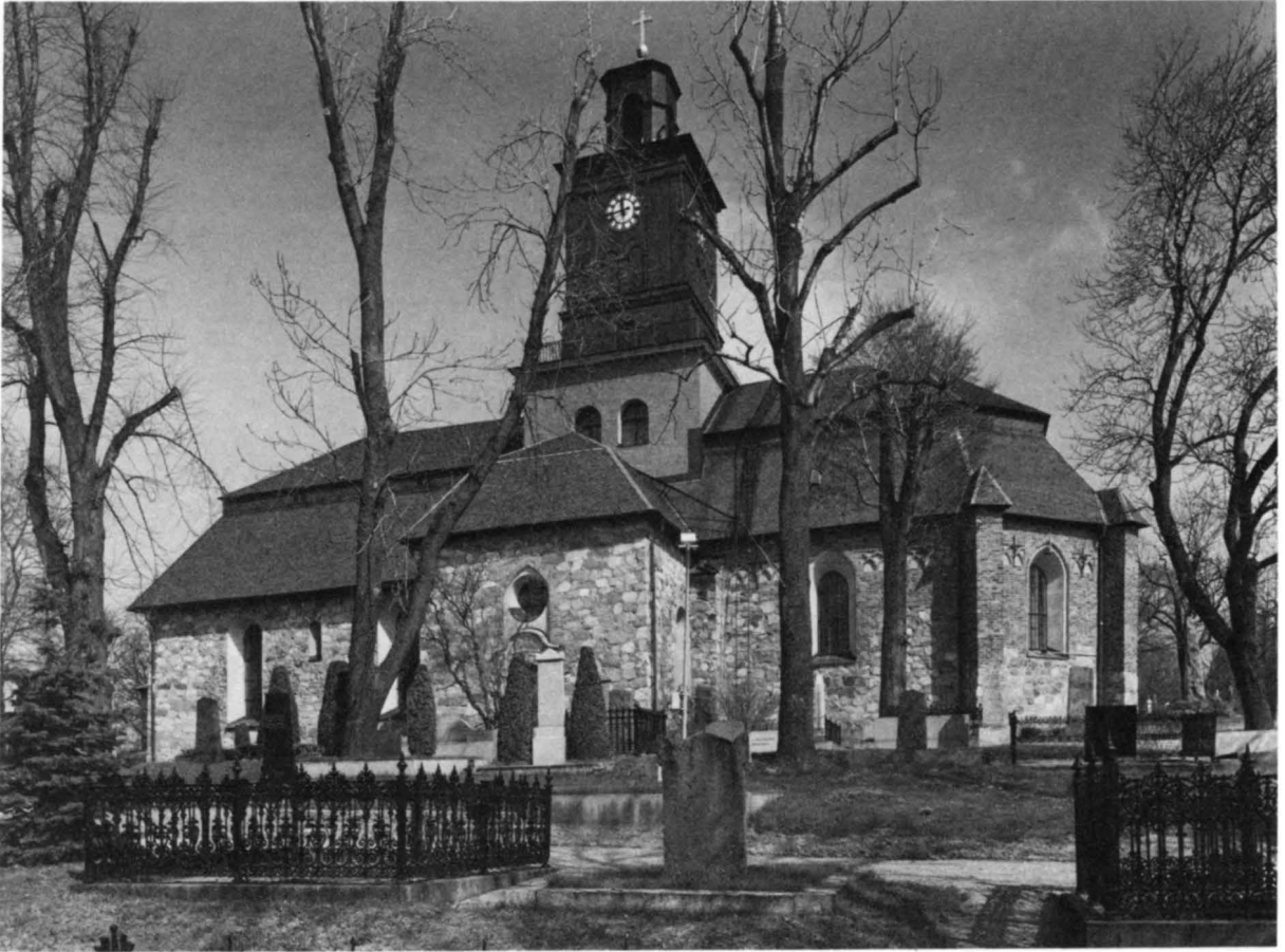
Fig 45. Kyrkan från sydost. Foto 1983.
