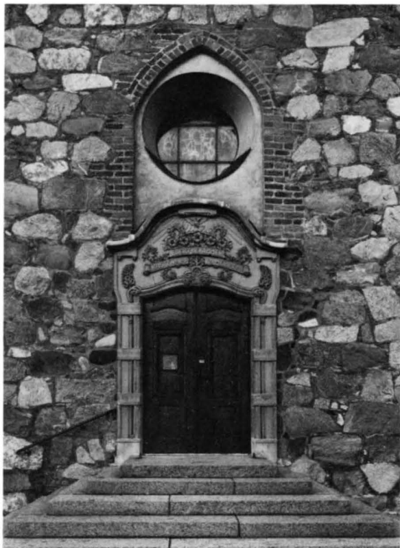
Fig 51. Portal i kyrkans södra korsarm, tillkommen vid en restaurering 1903–04. Däröver rester av ett medeltida fönster. Foto 1983.
