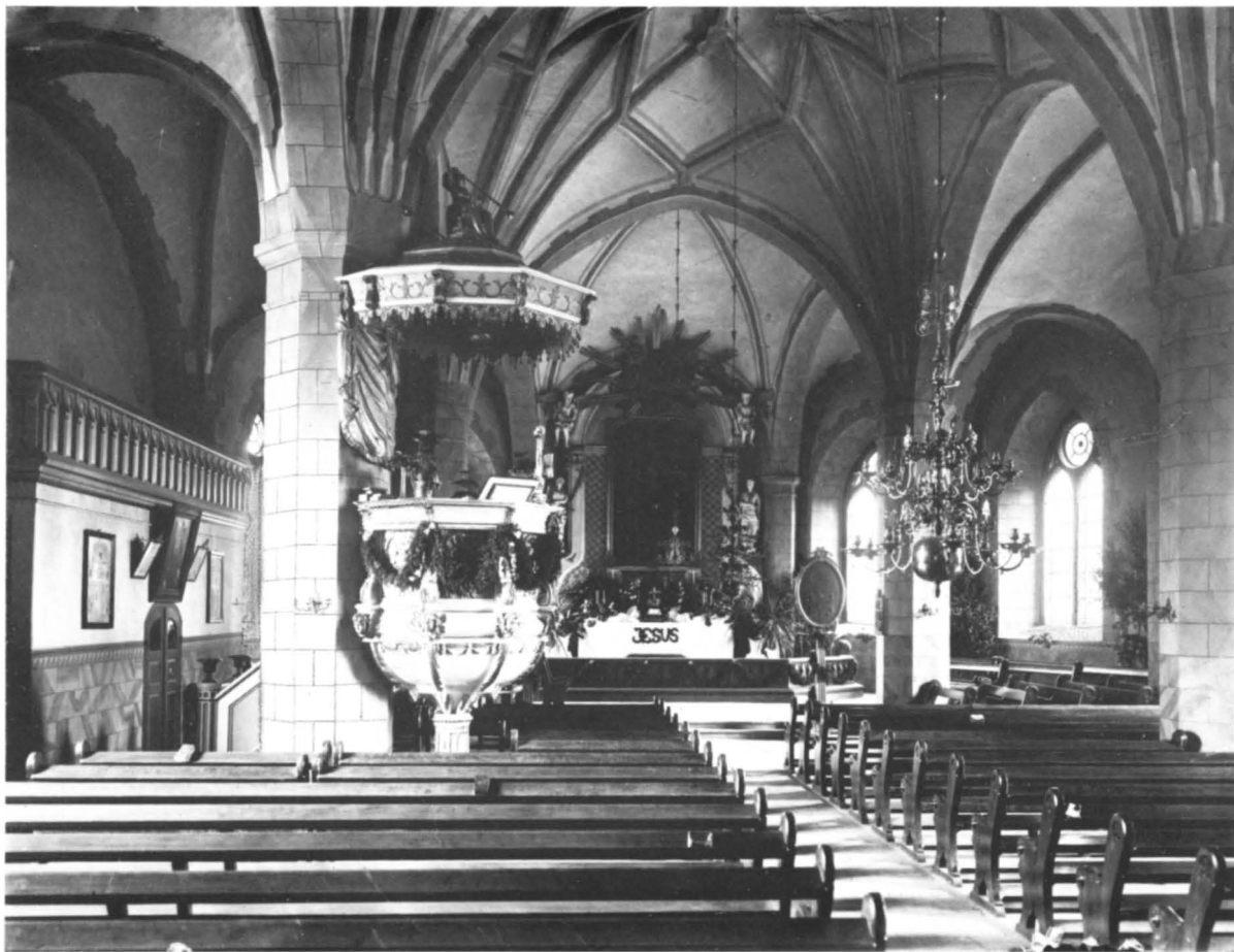
Fig. 58. Interiör mot öster efter 1895 års restaurering. Foto: Berta Hallgren. (Mora bygdarkiv.)
