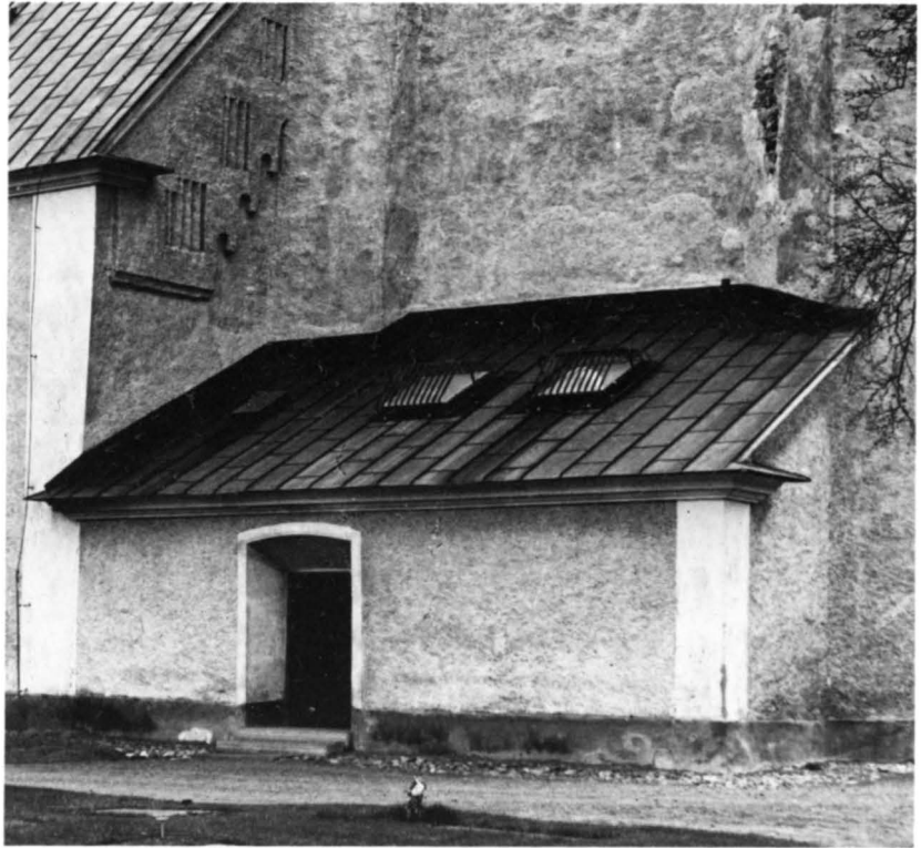
Fig. 46. Brudkammaren från nordväst. Foto: Kjells Foto AB 1983.
