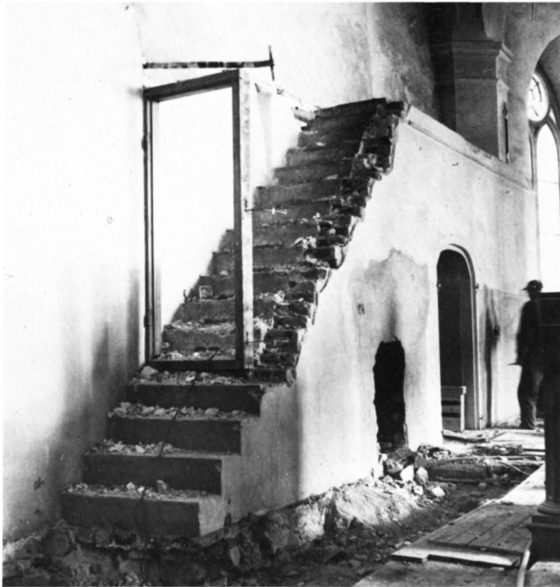
Fig. 45. Gapskulle-muren under rivning 1964. Foto: 1964. (KyA.)
