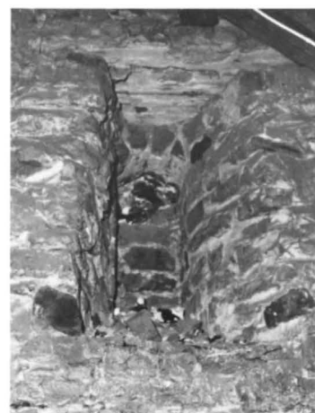
Fig. 20. Utvändigt svagt spetsbågig öppning i västgavelns äldsta del, gavelröstets spets, sedd från kyrkvinden. Foto: Kjells Foto AB 1983.
