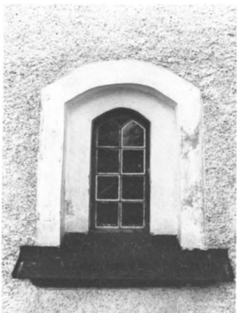
Fig. 30. Ursprungligt fönster i vapenhusets södra vägg. Foto: Kjells Foto AB 1982.
