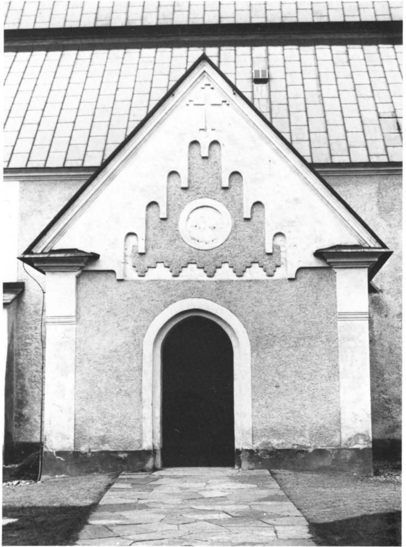
Fig. 37. Vapenhuset från söder. Foto: Kjells Foto AB 1982.
