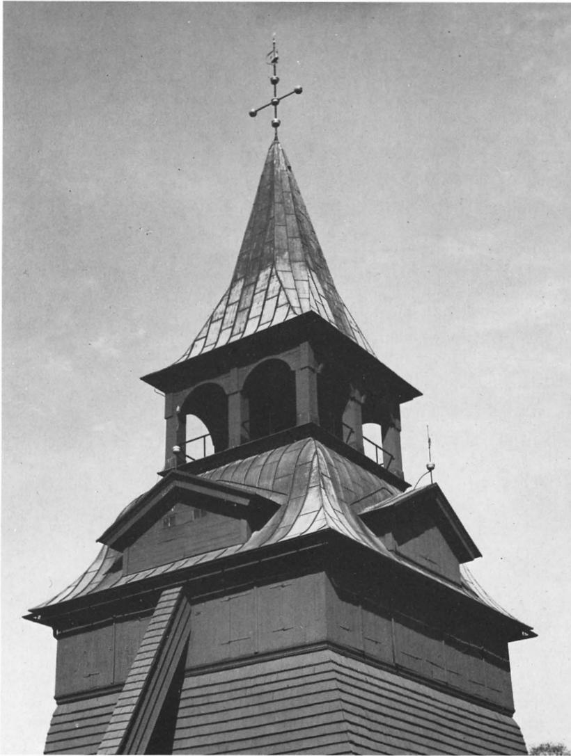
Fig. 9. Klockstapelns övre delar från sydväst. Foto: Kjells Foto AB 1983.
