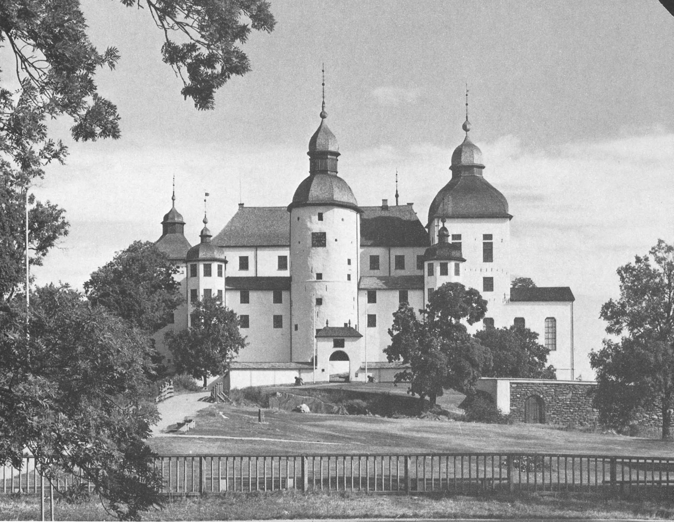
Fig 2. Läckö slott från söder. Slottet har formats under flera århundraden. Rester av en borg från 1200-talets slut utgör fundament till senare byggnader. Under 1600-talet tillbyggdes och förhöjdes slottet. Kyrkan tillhörde de första byggnadsplanerna 1654. Inredningsarbetet avslutades först 1669. Foto 1984.
