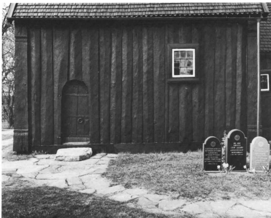
Fig 113. Hedareds stavkyrka. Långhusets södra fasad. Foto R Hintze 1981.
