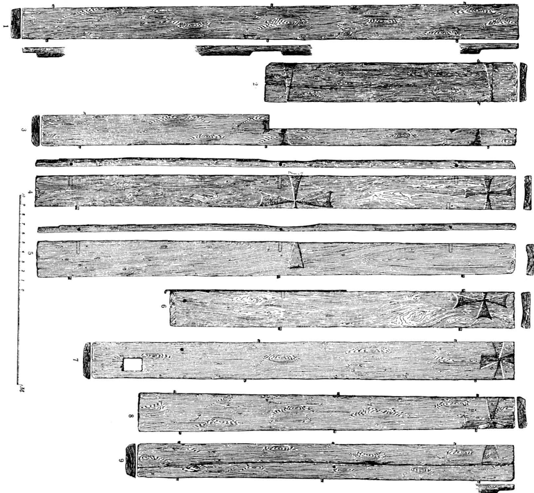
Fig 288. Mosjö. Vägglankor med inskurna kors, troligen från en skiftesverkkyrka. Efter Ekhoﬀ.
