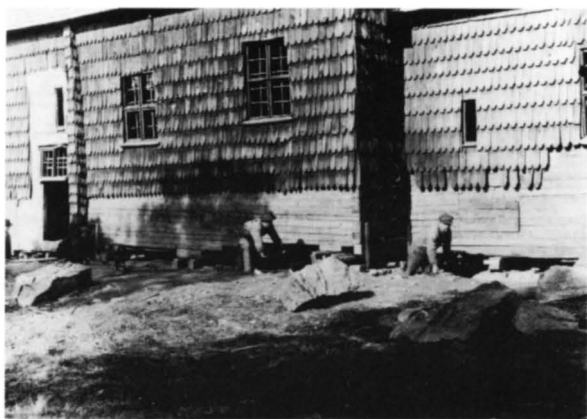
Fig 242. Södra Råda, kyrkobyggnaden under restaurering 1913, södra sidan. Foto O Hökerberg.
