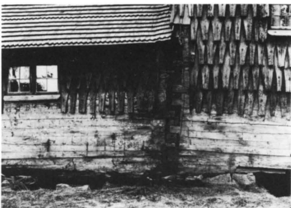
Fig 244. Södra Råda, kyrkan under restaurering 1913, norra sidan, skarven mellan långhuset och sakristian. Foto O Hökerberg.
