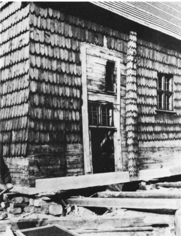
Fig 248. Södra Råda, kyrkan under restaurering 1913, långhusets sydvästra hörn med ursprunglig ingång upptagen. Foto O Hökerberg.
