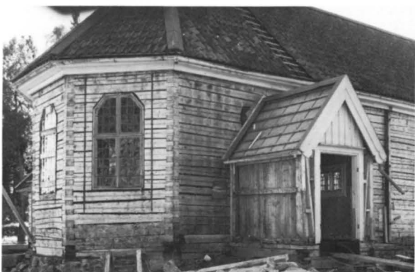
Fig 156–158. Brämhults kyrka under renovering 1951, brädpanelen borttagen. Foto i Borås kyrkoarkiv.
