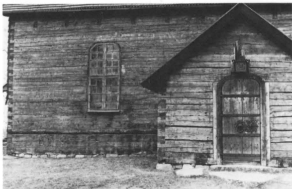
Fig 92 –97. Älgårås kyrka. Väggaras spånbeklädnad avlägsnad 1964. Foto A Andersson 1964, Älgårås. – 92. Långhusets sydvästra hörn. – 93. Knutningen mellan kor och långhus, södra sidan. – 94. Sydvästra hörnet. – 95. Långhusets nordvästra hörn. – 96. Långhusets södra vägg samt vapenhuset. – 97. Vapenhuset.
