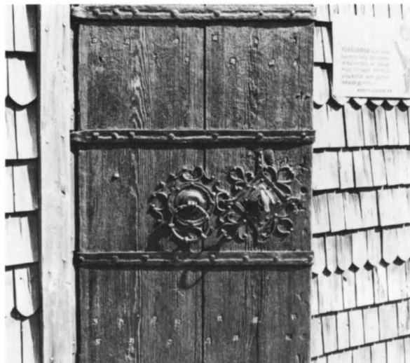
Fig 99. Älgårås. Detalj av dörren. Foto L Hasselbeg 1979.
