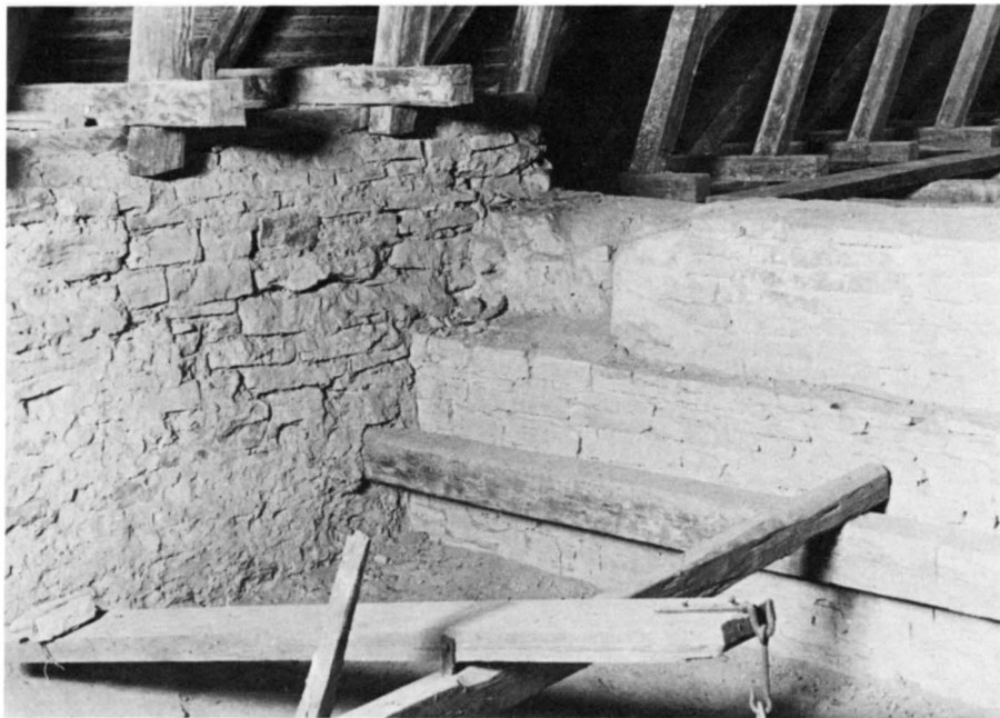
Fig 54. Korvindens sydvästra hörn. I förgrunden samma hävstång som i fig 53. T h triumfmurens påmurning från period IV, t v murverk och en ankarbjälke från 1826 (period IX). I mitten på bilden rester av en passage mellan korvinden och långhusvinden. Foto A Edle 1935.
