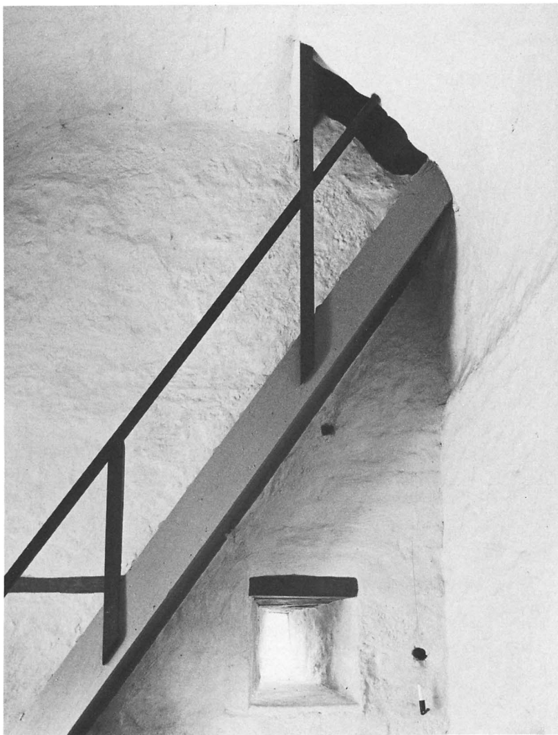
Fig 63. Västtornets bottenvåning, det nuvarande vapenhuset, nordöstra hörnet med trappan upp till tornvinden. Observera ljusgluggens avtäckning av ek och två ställningshål. Foto R Hintze 1982.
