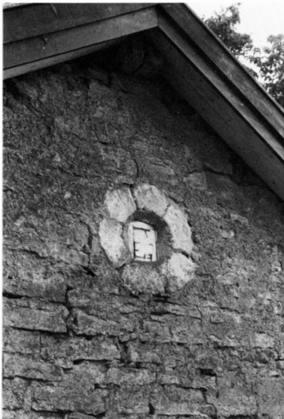
Fig 69–70. Rundfönster med omfattning av sex huggna stenar, nu i Smedstugans gavel (fig 10 D, 17). Fönstret har ursprungligen med all sannolikhet suttit först i absiden (fig 71), sedan i östtornet. Foto R Boström 1985.
