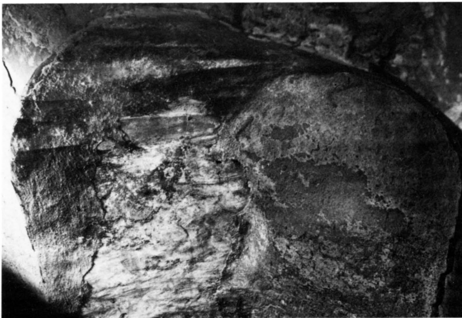
Fig 48 a–b. Sekundärt, igenmurat fönster i absiden, bakom altaruppsatsen. Högst upp i fönstervalvet skymtar kvadermålning i rött, grått och vitt (jfr fig 29, 32 och 76). Foto JLM/O Westerudd 1985.
