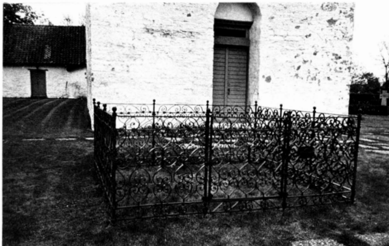
Fig 18. Grav med gjutjärnsstaket (nr 8), väster om kyrkan, över f d äldermannen Olof Nilsson, Karlsberg, † 1881. I bakgrunden t v sakristian. Foto R Boström 1983.
