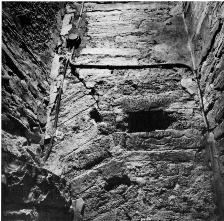
Fig 51. Övre korttrappan. Detalj av östra muren med absidens omfattningsbåge, murad av kalktuff och kalksten samt med kvaderits. Foto KLM/R Lind 1987.
