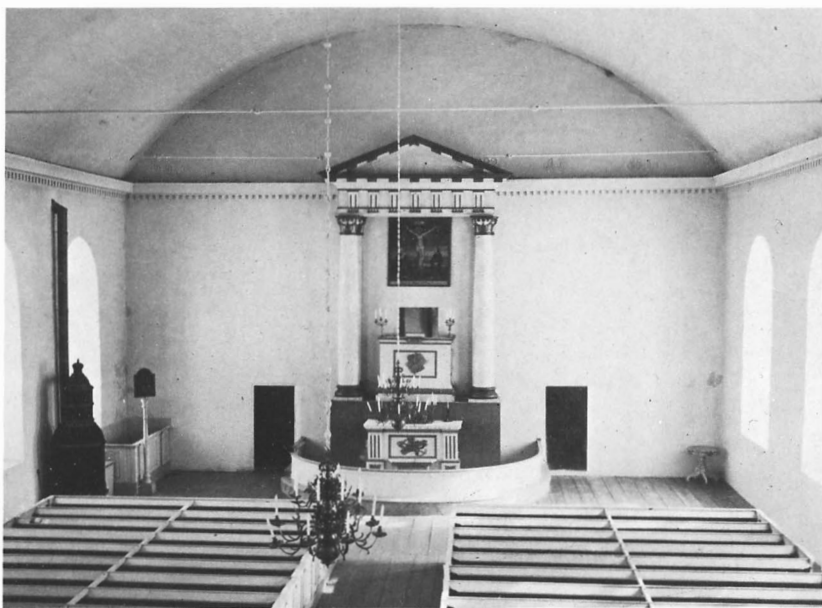
Fig. 114. Interiör mot öster före restaureringen 1926. Foto: ATA 1924.
