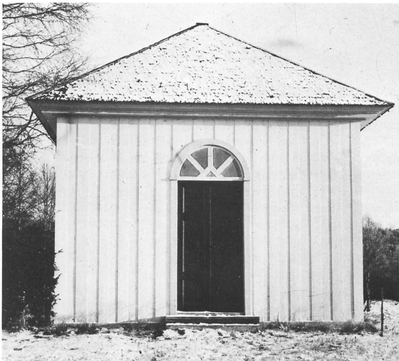
Fig. 97. Bårhus av trä, uppfört 1880 och rivet 1957. Foto: ATA.
