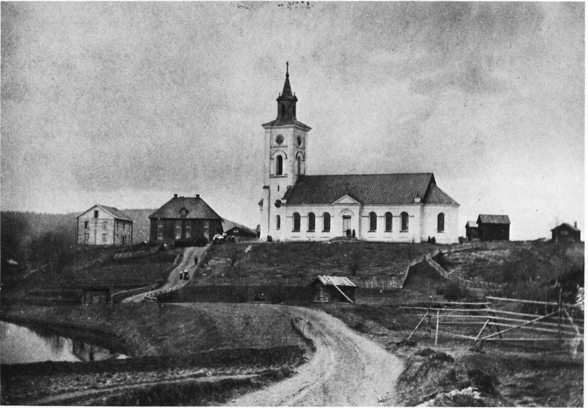
Fig. 24. Lima kyrka med omgivningar från söder. Nya prästgården är under byggnad, varför fotot kan vara taget tidigast 1866.
