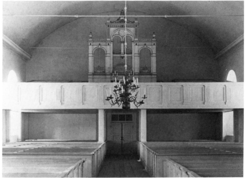
Fig. 115. Interiör mot väster före restaureringen 1926. Foto: ATA 1924.
