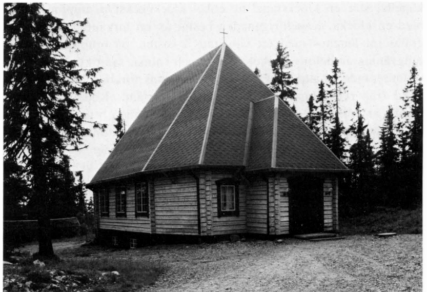
Fig. 183. Exteriör från nordväst. Foto: Petterssons Foto, Evert Mattsson, 1984.
