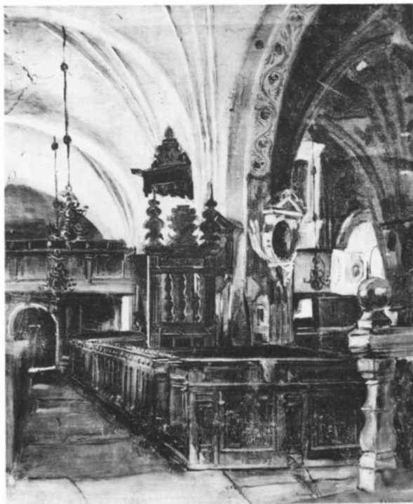
Fig 47. Interiör av långhuset före 1880-talets ombyggnad. Oljemålning av Oscar Björk.
