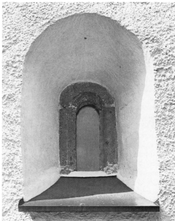
Fig 52. Östra korfönstrets yttre omfattning och smyg. Foto R Hintze 1983.
