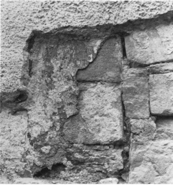
Fig 53. Stötfog, som markerar den igenmurade korportalens västra smyg i södra korväggen. Foto K Andersson 1971.
