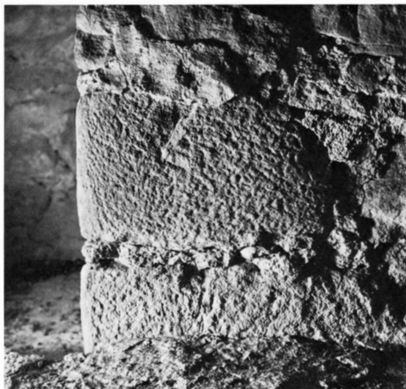
Fig 37. Ytbehandling av hörnsten i muröppning på vinden. Foto K Andersson 1972.
