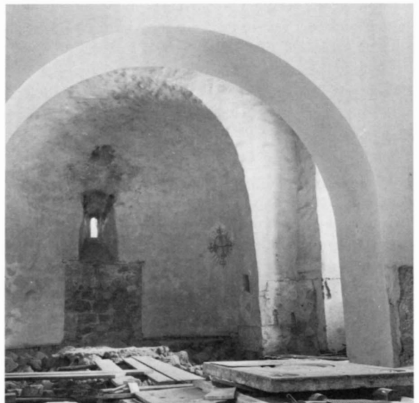
Fig 50. Koret med delvis borttagen stenpackning i absidens golv. Foto K Andersson 1971.
