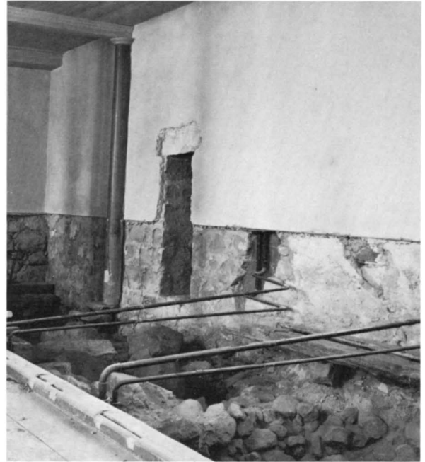
Fig 62. Framtagen dörröppning till trappa i tornets norra mur. Foto K Andersson 1971.
