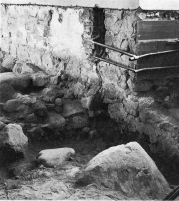
Fig 61. Ilagning i sydväggen efter muren mellan långhus och torn. Tv syns rester av dennas grundmur. Foto K Andersson 1971.
