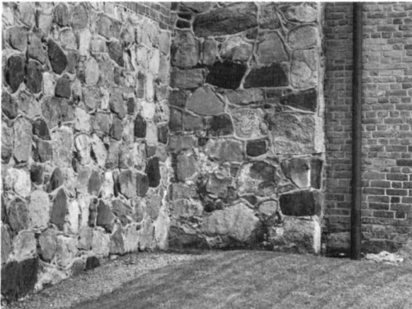
Fig 33. Parti av västfasaden söder om tornet. Foto GH 1987.
