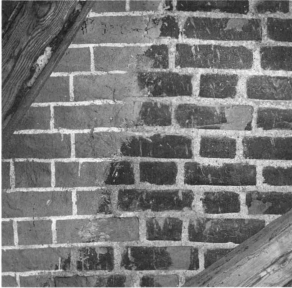
Fig 67. Tornet, östsidan mot vinden, murverk med puts och fogmålning. Foto GH 1987.
