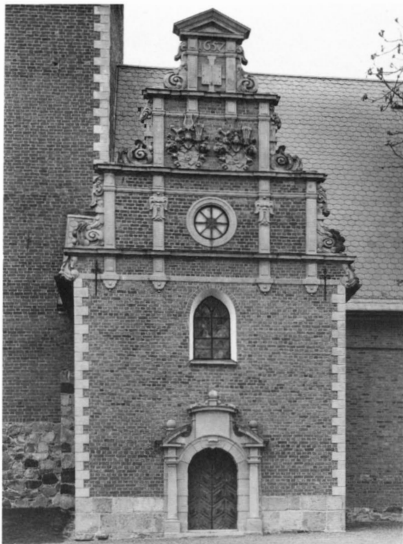
Fig 36. Vapenhuset, från söder. Foto GH 1987.
