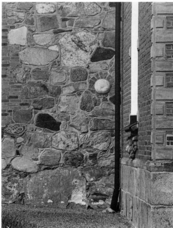
Fig 28. Parti av sydfasaden mellan vapenhuset och Braheska gravkoret. Foto GH 1987.
