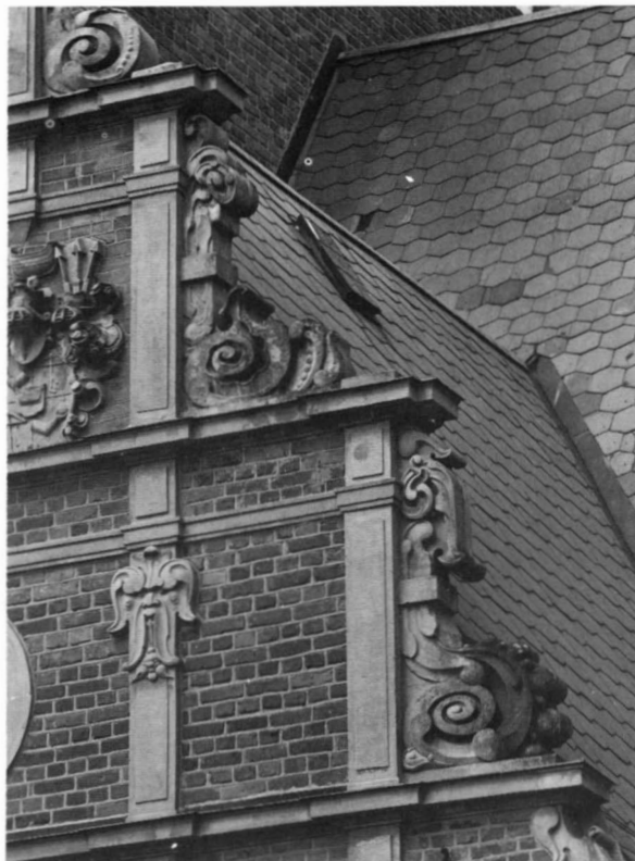
Fig 37. Vapenhuset, detalj av gaveln. Foto GH 1987.
