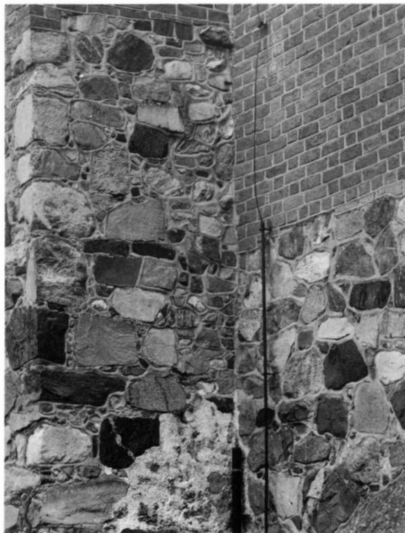
Fig 29. Parti av västfasaden närmast tornet. Foto GH 1987.
