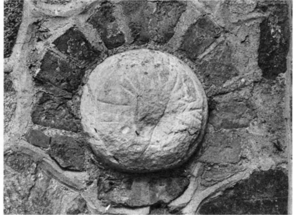
Fig 32. Gravklot, inmurad i sydfasaden. Foto GH 1987.
