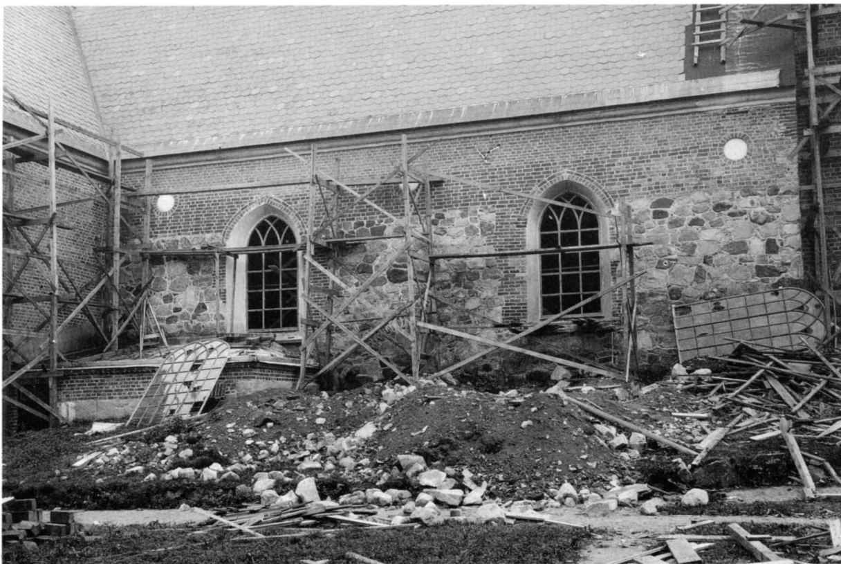
Fig 87. Kyrkan från norr under pågående grävning och restaurering 1934. De äldre bågarna från 1820-talet återinsatta. På marken ligger bågarna från 1880. Foto P O Westlund 1934. ATA.
