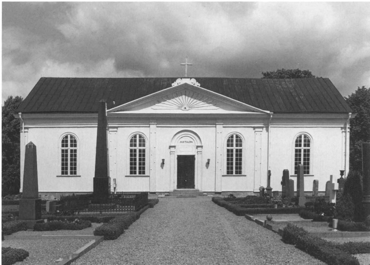
Fig 338. Eringsboda kyrka i Blekinge, även den en träkyrka, uppfördes 1847–49 som ett litet tornlöst tempel efter ritning av J A Hawerman. Timmerkonstruktionen döljs bakom en vitmålad slätpanel och smäckra pilastrar i fulländat symmetrisk komposition.
