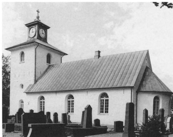
Fig 207. Starby kyrka från sydöst. Starby Church from the south-east.
