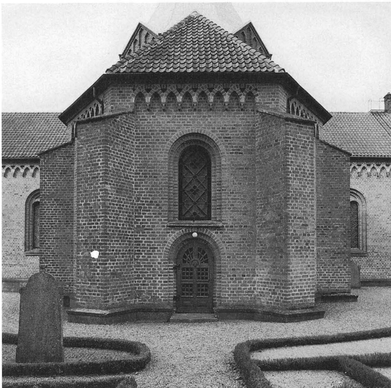
Fig 22. Tullstorps kyrka, uppförd av tegel i kryssförband. Jfr fig 17
