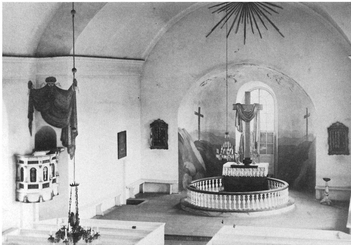
Fig 112. Interiör mot öster av Listerby kyrka före restaureringen 1947. Foto ATA.
