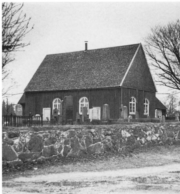
Fig. 318. Sillhövda kyrka från sydöst. Nedbrunnen 1940. Foto ATA.
