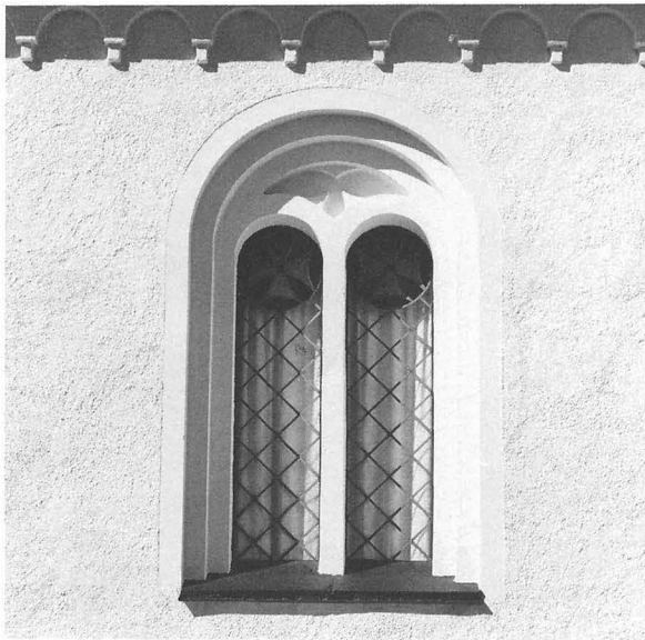
Fig 149. Ett av långhusets fönster. Nave window.
