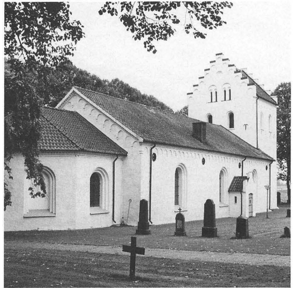
Fig 116. Ausås kyrka från nordöst. Ausås Church from the north-east.
