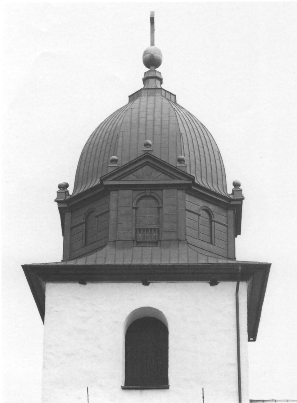
Fig 329. Den elegant svängda huvan från 1790 på Örkeneds kyrka pryds av fint proportionerade klassiska tempelgavlar. Det uttrycksfulla formspråket framhävs av ett skickligt plåtslageriarbete.
