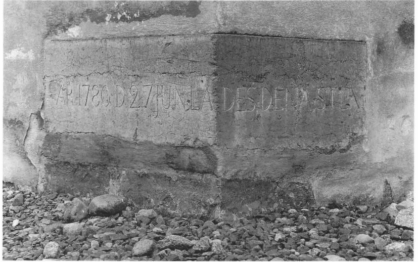
Fig. 132. Finhuggen hörnsten av sandsten i södra korsarmens östra hörn, enligt inskrift lagd 27 juni 1780. Foto: Bengt Mattsson 1987.
