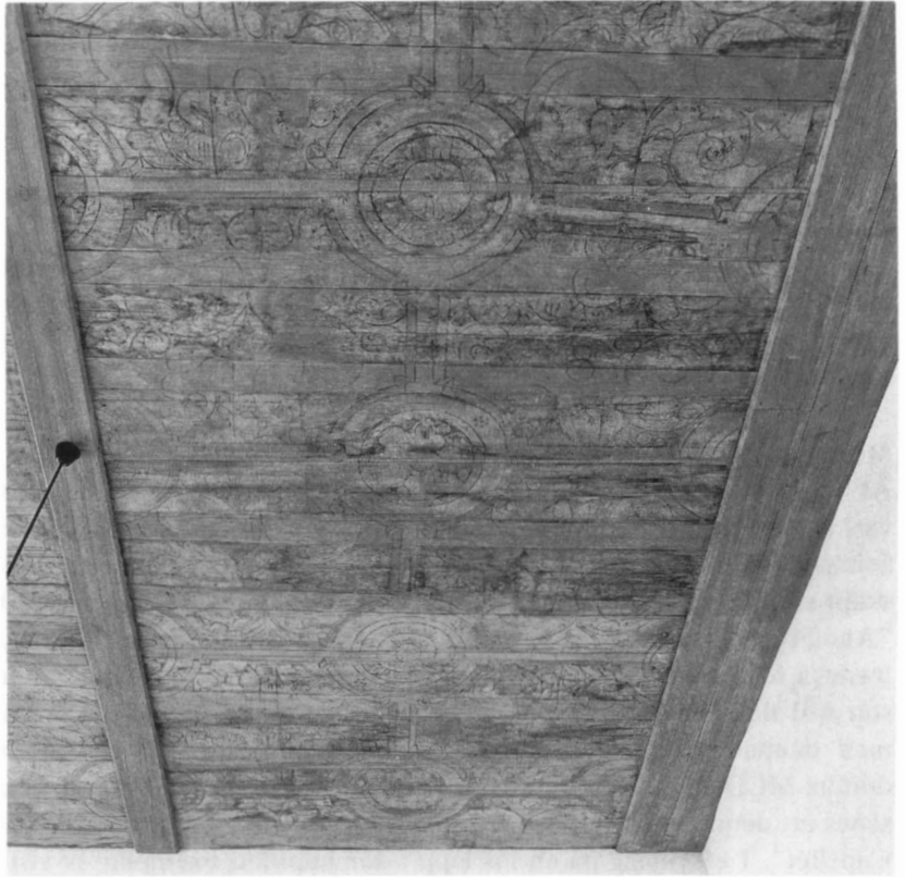
Fig. 218. Målade bräder från gamla kapellets tak, uppsatta 1953–1954 som innertak i tornets bottenvåning. Foto: SvK 1985.
