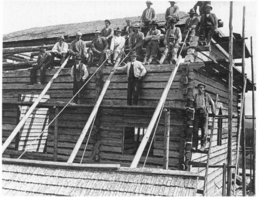
Fig. 99. Kättbo kapell under ombyggnad 1918–1919. Arbetslaget uppradat på taket. Foto i privat ägo.
