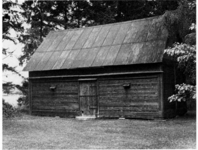
Fig 772. Sockenmagasin uppfört i skiftesverk 1863. Foto 1990.
