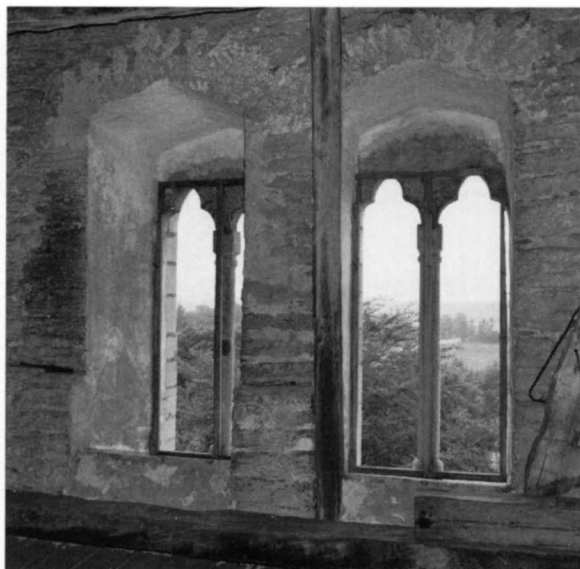
Fig 808. Klockvåningens västra mur, ljudöppningarnas inre omfattning. Foto 1985.
