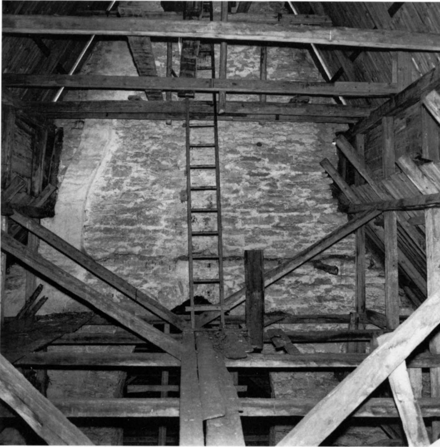
Fig 810. Långhusets vind mot öster, takstolens övre del. Foto 1965.
