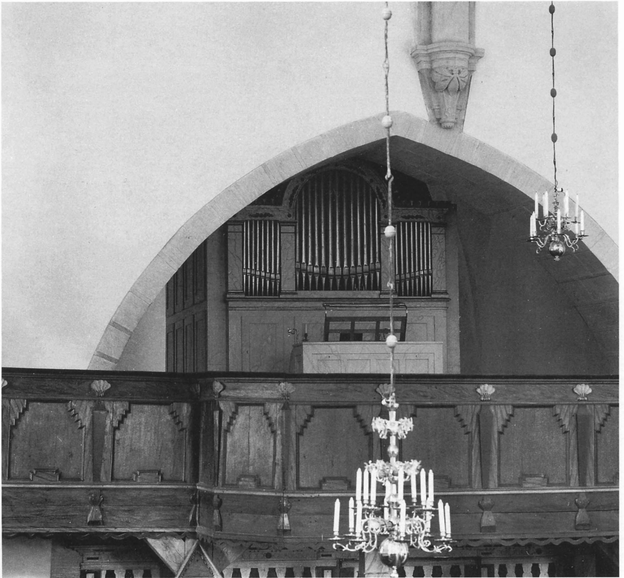
Fig 861. Läktaren byggd 1758 och målad 1768 samt orgelfasad från 1861. Foto 1985.
