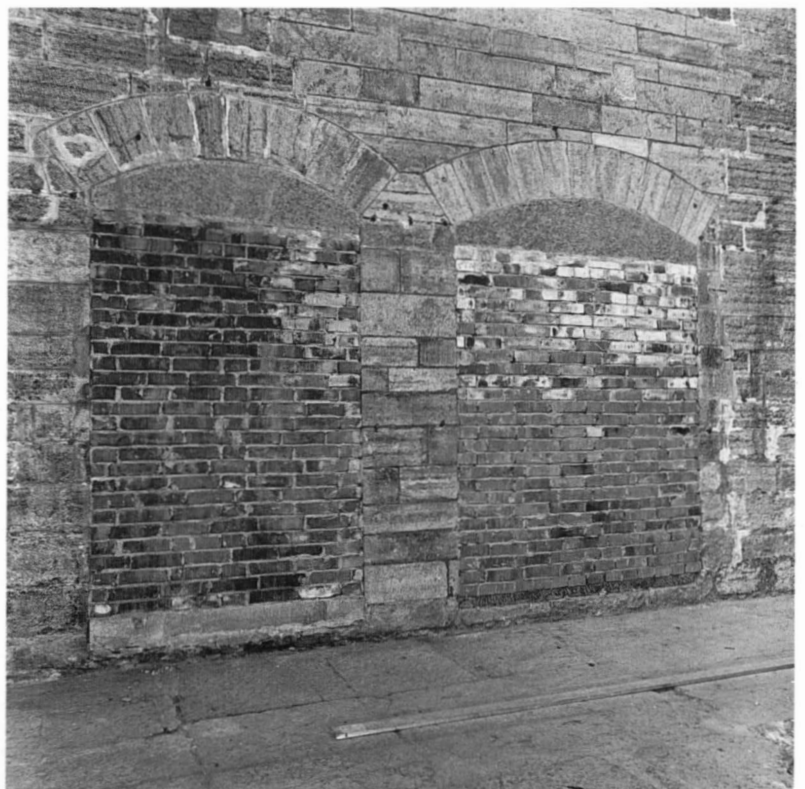
Fig 34. Två igensatta ingångar i korets västmur. Den vänstra är troligen ursprunglig men sattes igen senast på 1600-talet (jfr fig 67). Den högra togs upp på 1820-talet och sattes igen på 1890-talet. Foto Å Svensson, Motala.
