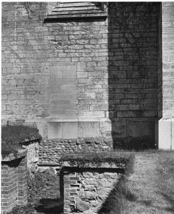
Fig 35. Korets västmur med spår efter en igensatt, troligen ursprunglig, ingång (jfr fig 34). I förgrunden rester efter klosters talehus.
