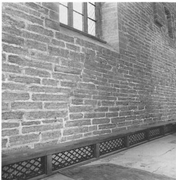
Fig 25. Långhusets nordvägg i tredje travén från öster. Under fönstret en förtagning i murverket, som visar att den östra delen av muren byggdes först. Foto Å Svensson, Motala.
