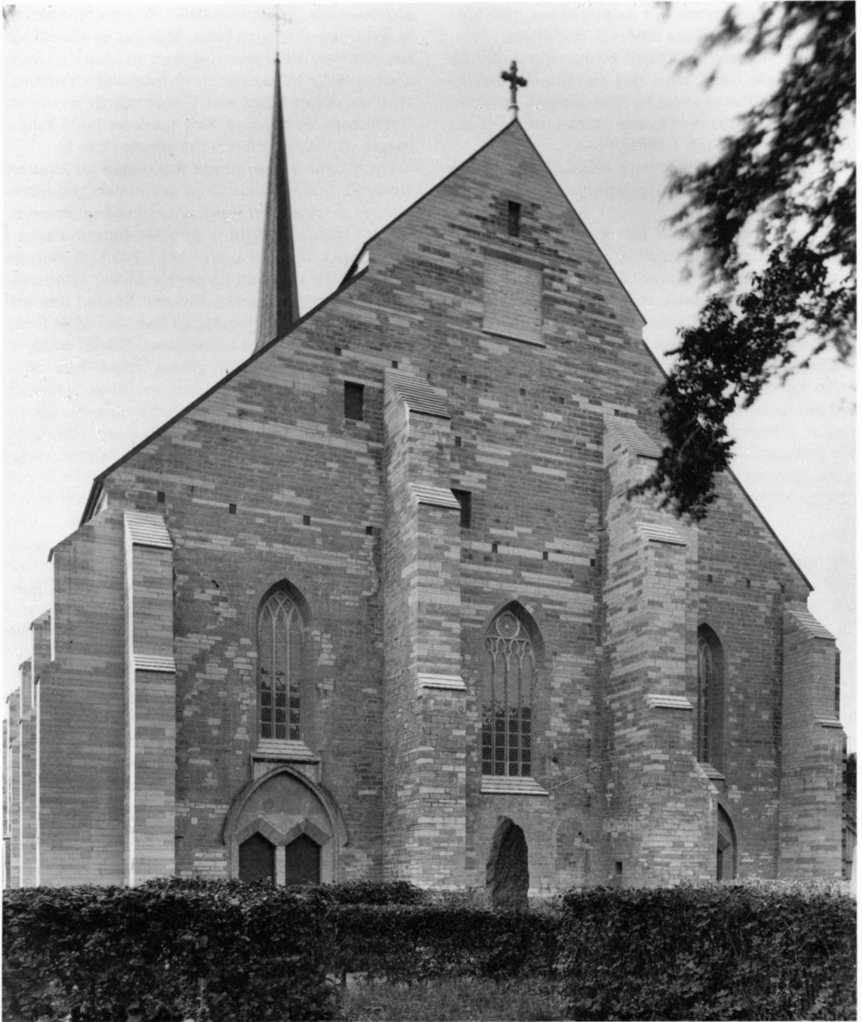
Fig 108. Klosterkyrkans östfasad. De ljusa partierna är stenar som bytts ut vid restaureringen. Foto S Curman 1905.
