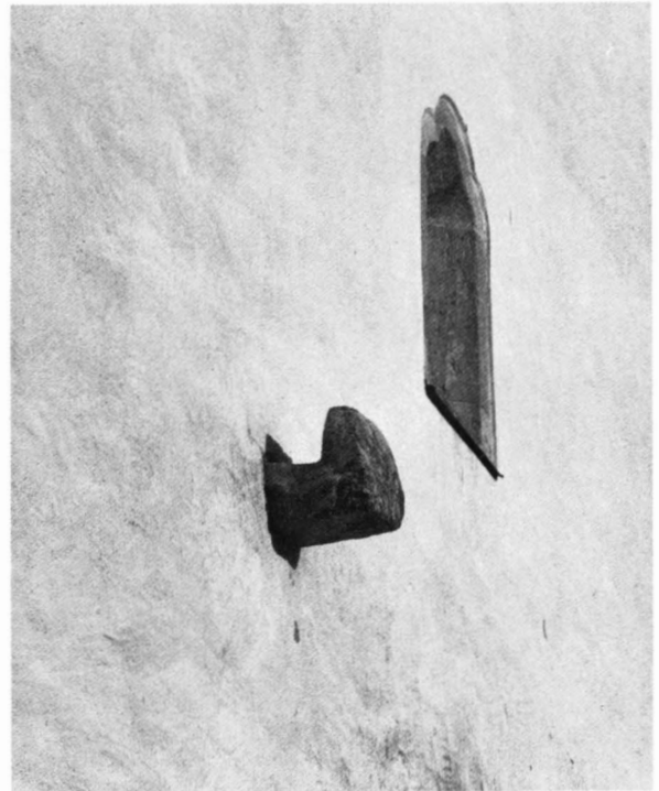
Fig 35. Kalkstenskonsol i tornets västfasad. Foto 1988.
