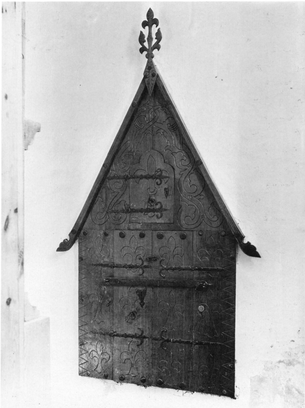
Fig 43. Sakramentskåp i korets norra vägg med omfattning och dörrar av ek. Den snidade och ristade ornamentiken samt beslagen är till största delen ursprungliga, men skåpet är hårt restaurerat 1902. Foto A Edle 1943.
