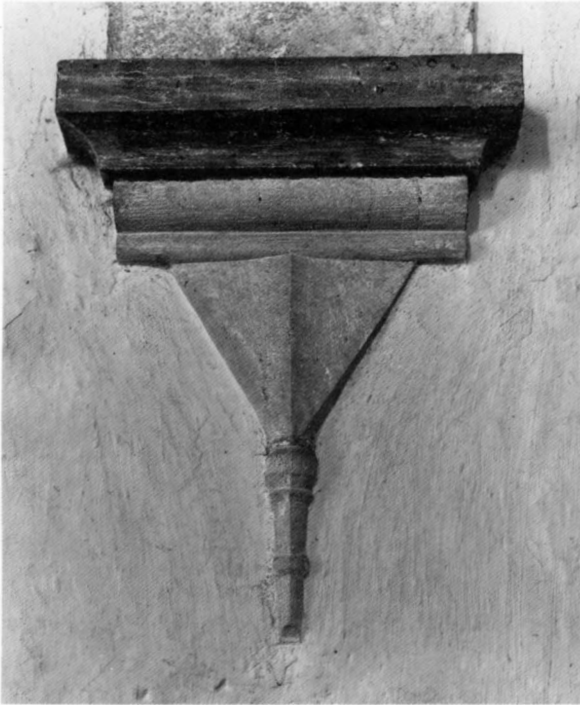
Fig 40. Valvkonsol på långhusets sydvägg. Foto A Edle.
