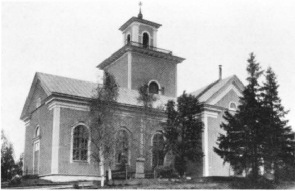
Fig 189. Haparanda-Nedertorneå gamla kyrka. Byggt 1823–25. Exteriör från nordväst. Foto 1930-talet. ATA.
