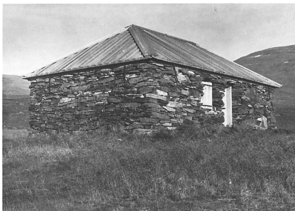
Fig 83. Alkavare kapell. Byggt 1788. Exteriör från sydväst. Foto Bert Persson, Luleå, 1967.
