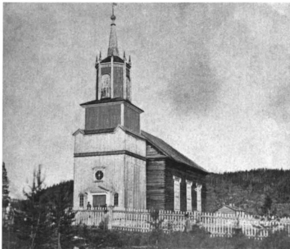
Fig 9. Malå kyrka. Byggd 1851–52. Äldre foto, före 1887, som visar kyrkan innan långhuset fick panel. ATA.
