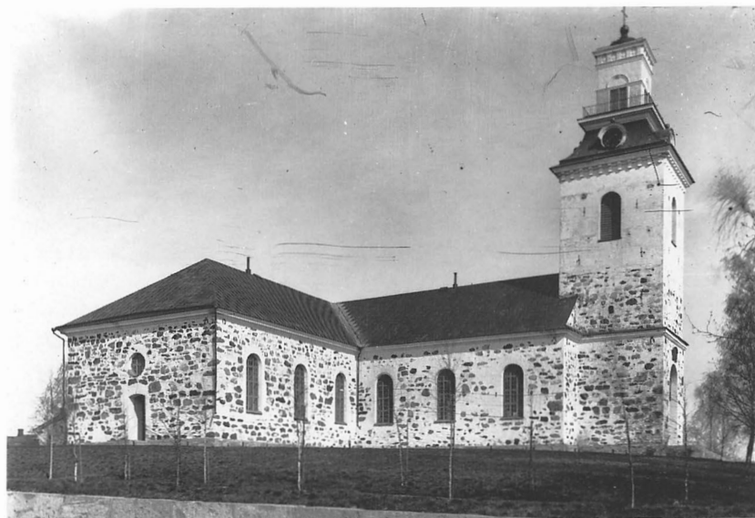
Fig 245. Kuopio kyrka. Byggt 1806-15. Finska fornminnesföreningen 1899. Foto Museiverket, Helsingfors.
