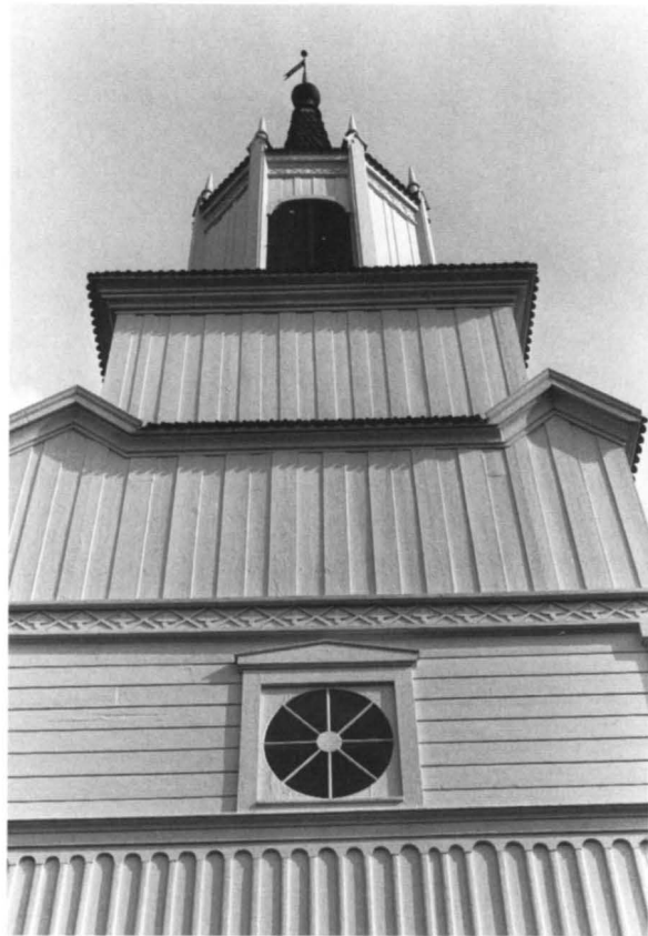
Fig 10. Malå kyrka. Västtornet med varierande typer av panel. Foto förf. 1990.
