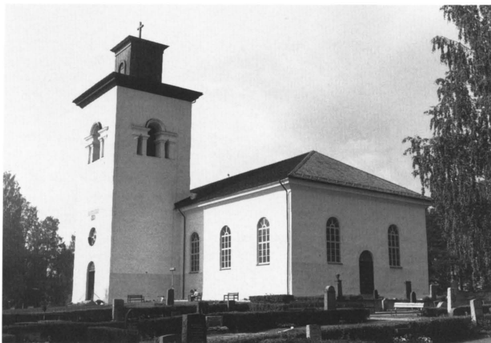
Fig 155. Överluleå kyrka. Byggt 1826–31. Exteriör från sydöst. Foto förf. 1989.
