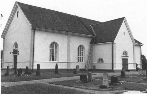
Fig 145. Vännäs gamla kyrka. Byggd 1817–25. Exteriör från sydväst. Foto förf. 1990.
