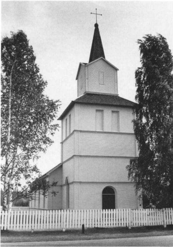
Fig 97. Hörnefors brukskyrka. Byggt 1796-omkr 1850. Exteriör från väster. Foto förf. 1990.
