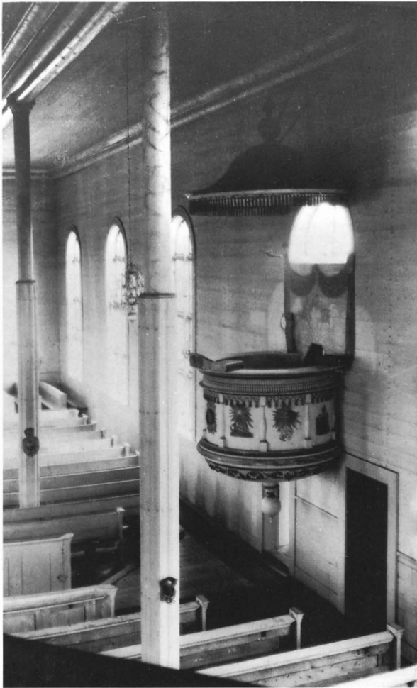
Fig 30. Överkalix gamla kyrka. Byggt 1856–58. Predikstolen uppsatt högt, mitt på norra långväggen. Foto E Lovén 1930. Foto ATA.
