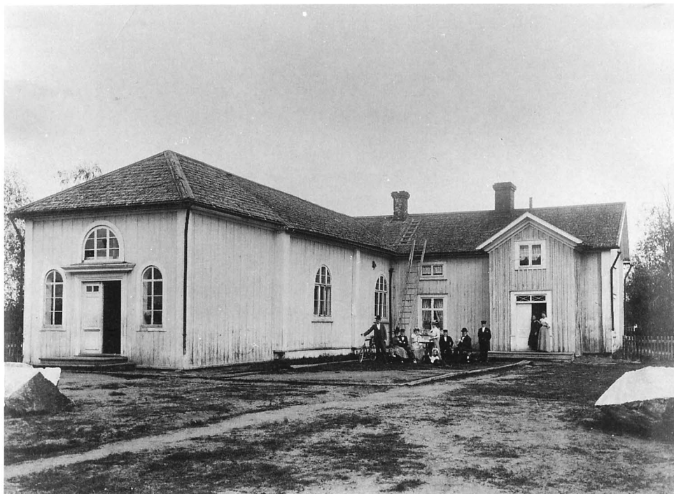
Fig 37. Ytterstfors brukskyrka. Byggd 1837-38. Exteriör 1875-1900. Kyrkan här ombyggd till skola med skolsal, torn-överbyggnaden riven (jfr fig 202). Koret utbyggt med en flygel innehållande lärarbostad. Foto Skellefteå museum.
