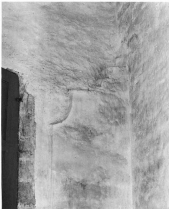
Fig. 39. Detalj av södra långhusmuren väster om portalen. Foto 1989.
