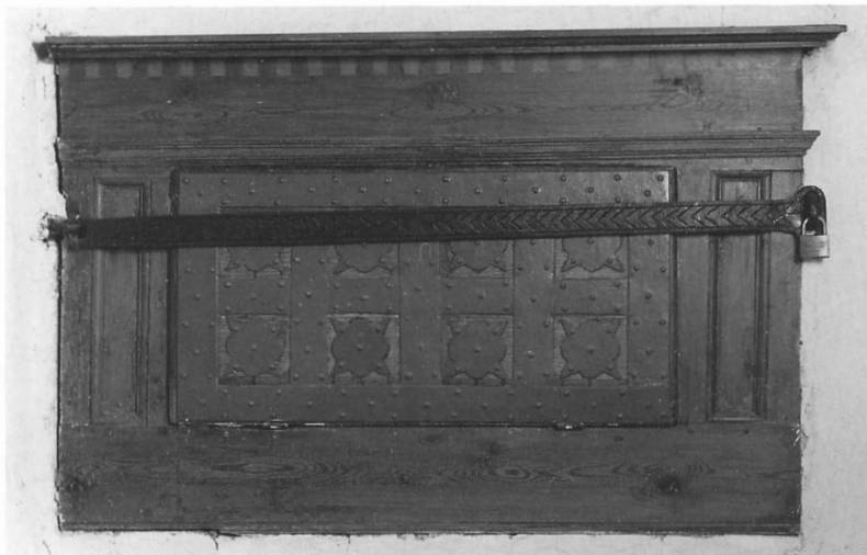
Fig. 32. Skåp i sakristians västra mur. Foto 1989.
