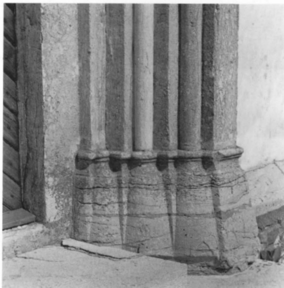
Fig. 21. Långhusportalens östra basparti. Foto 1982. The east base section of the nave doorway.
