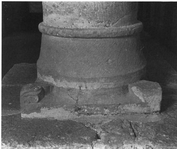
Fig. 42. Långhuspelarens bas från öster. Foto 1989. The base of the pillar in the nave seen from the east.
