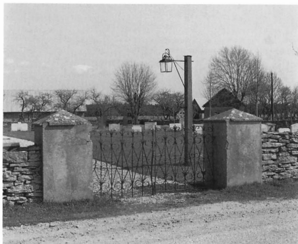
Fig. 7. Kyrkogårdens västra ingång. Foto 1982. The west entrance to the churchyard.
