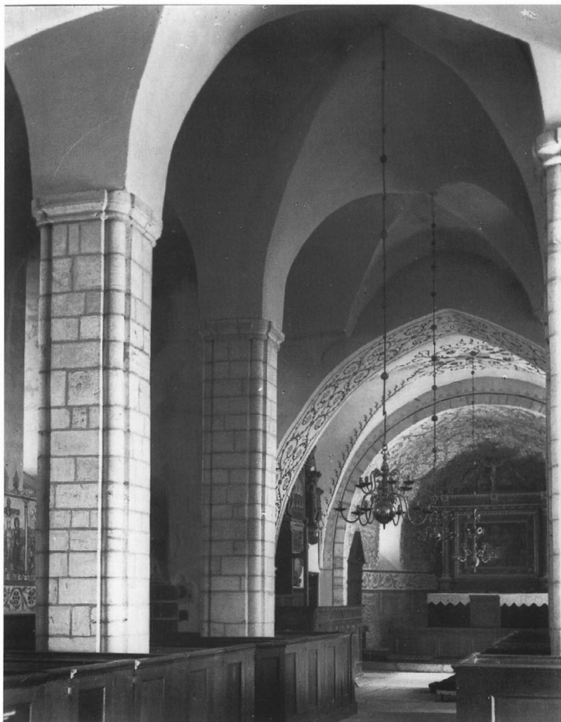
Fig. 59. Interiör mot öster före restaureringen 1956-57. Foto i ATA.
