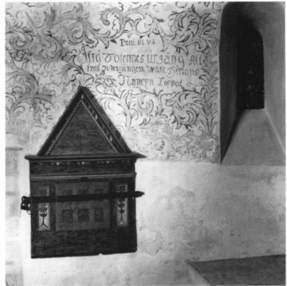
Fig. 63. Absidens norra mur med ursprungligt fönster och sakramentsskåp med omfattning från 1600-talet. Foto 1994.
