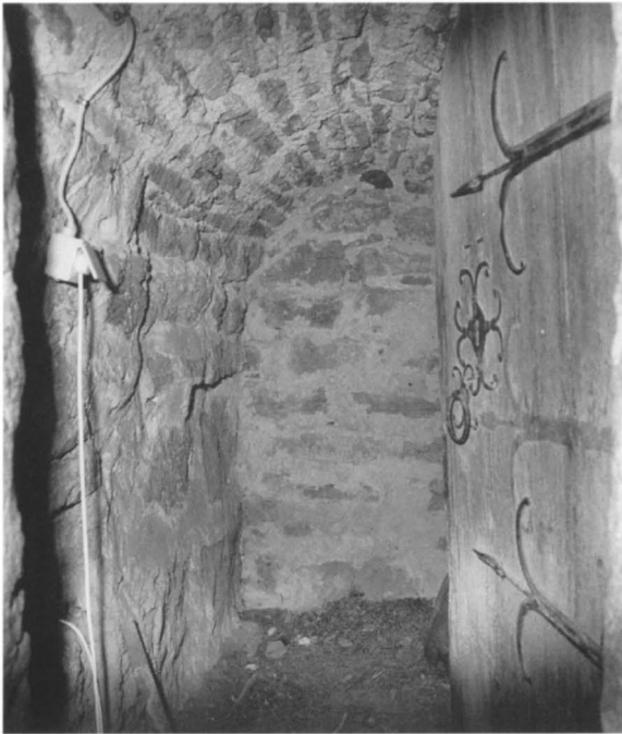
Fig. 51. Tunnvälvd kammare i tornets östra mur, i murtrappans förlängning. Foto 1994.
