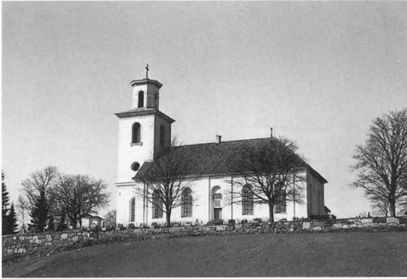
Fig. 324. Häggdångers kyrka från söder. Byggt 1784–85, delvis på medeltida grundmurar. Tornet byggt 1848. Foto K. O. Kjerlander, Länsmuseum Västernorrland.
