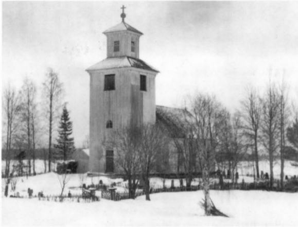
Fig. 111. Alanäs gamla kyrka från nordost. Byggd troligen 1808, torn från 1839. Vid rivningen 1930 omvandlades tornets nederdel till gravkapell. Foto 1920-talet. ATA.
