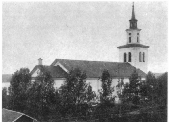
Fig. 114. Alsens kyrka från sydväst. Färdig 1847, nedbrunnen 1919. Foto ur Jämten 1919.
