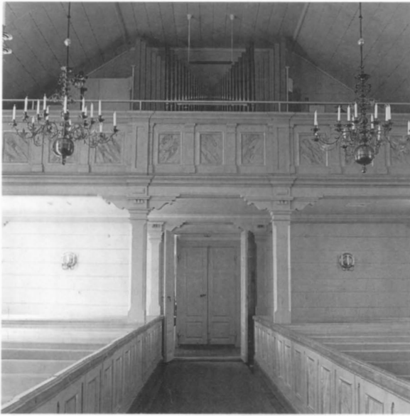
Fig. 193. Nyhems kyrka. Interiör mot väster. Foto BJ 1995. Nyhem Church. The interior looking west.
