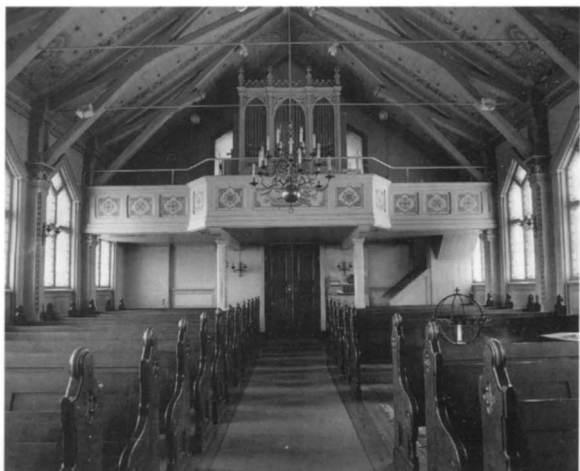
Fig. 271. Svartviks kyrka. Interiören sedd mot söder. Foto Peter Hamberg, Sundsvalls museum, 1966. Svartvik Church. The interior looking south.
