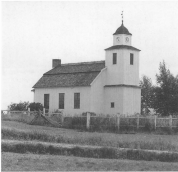
Fig. 97. Storsjö kapell från nordväst. Byggt 1751 utan torn, flyttat till sin nuvarande plats 1812 varvid kyrkorummet utvidgades och tornet byggdes. Foto CM 1975.
