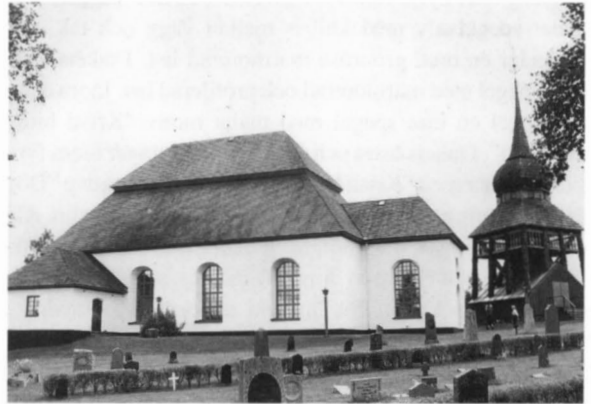
Fig. 150. Hallens kyrka från norr. Byggt 1775–76 på delvis medeltida murar. Sakristia och vapenhus från 1956. Klockstapelns byggd 1756. Foto AT 1991.
