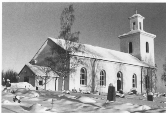
Fig. 335. Långsele kyrka från sydväst. Byggt 1826–27, vapenhuset i väster byggt 1956. Foto AT 1982.
