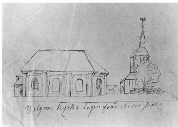
Fig. 317. Helgums kyrka och klockstapel från norr ca 1828. Klockstapeln byggd 1772, riven då tornet byggdes 1854. Teckning i Ekdahls samling. ATA.
