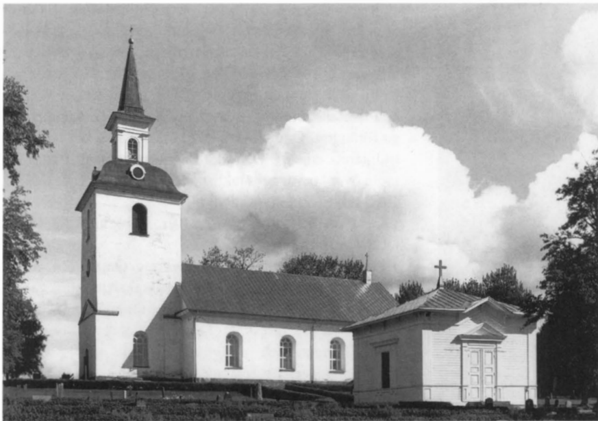
Fig. 194. Offerdals kyrka från söder. Byggt 1766–68, delvis på äldre murar. Tornet byggt 1814. Foto AT 1991.
