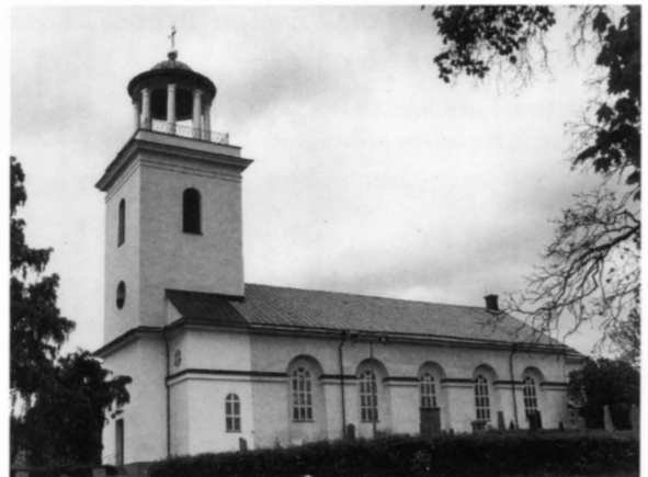
Fig. 272. Timrå kyrka från sydväst. Byggd 1794–96, delvis på medeltida grundmurar. Tornets övre partier är från tiden 1833–35. Foto ATA 1991.
