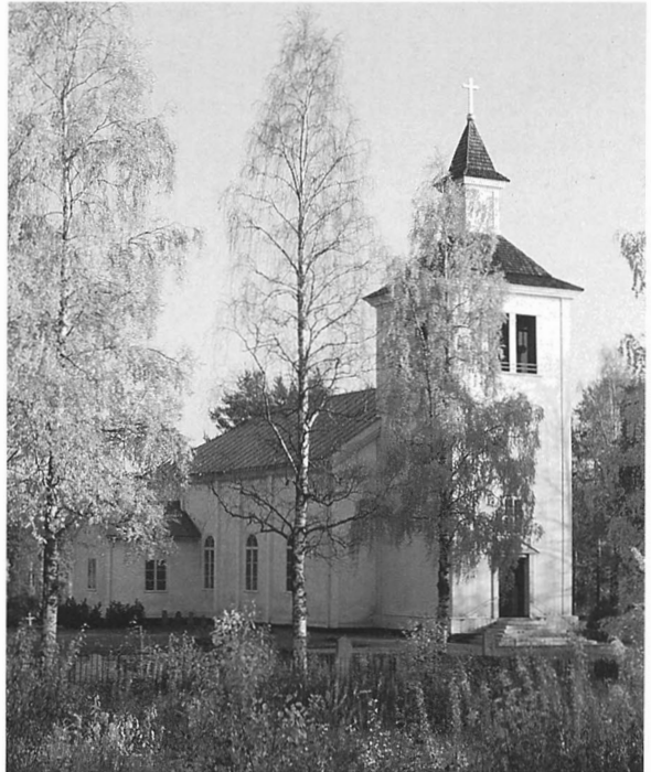
Fig. 372. Trehörningsjö kyrka från nordväst. Byggd 1836, tornet troligen 1882. Foto AT 1982.
