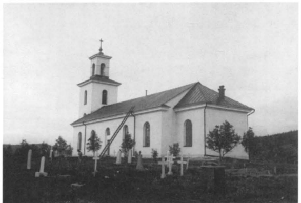
Fig. 287. Bjärträ kyrka från sydöst. Byggd 1844–47. Foto Nilsson, Sollefteå, 1898. Reprofoto ATA.
