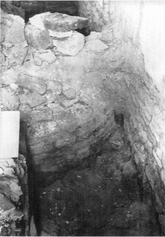
Fig 24. Ett stycke av korets och absidens grundmur från söder. Till höger den nya kormuren från 1811. Foto KLM/M Hofrén 1931.
