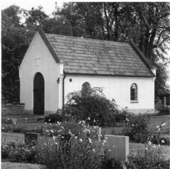
Fig 12. Bårhuset i kyrkogårdens nordöstra hörn, ritat och byggt 1915 av byggmästaren C A Svantesson i Mörbylånga (fig 10:K). Foto R Hintze 1983.
