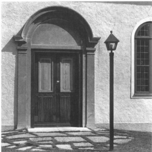
Fig 79. Långhusets sydportal. Omfattningen av röd kalksten tillkommen 1931. Dörrarna och inskriftstavlan från 1811. Foto R Hintze 1983.
