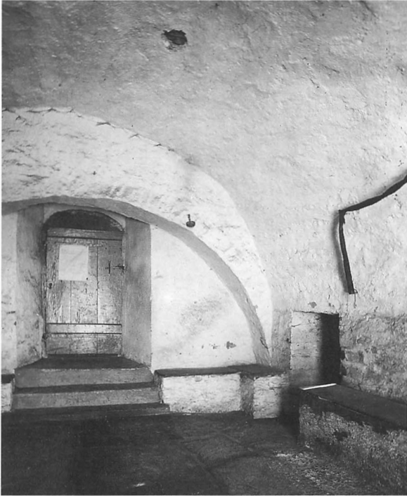
Fig 37. Interiör av tornets bottenvåning mot sydöst efter ombyggnaden 1811, då tornbågen igensattes och försågs med dörroppning i till långhuset. Foto A Roland 1917.
