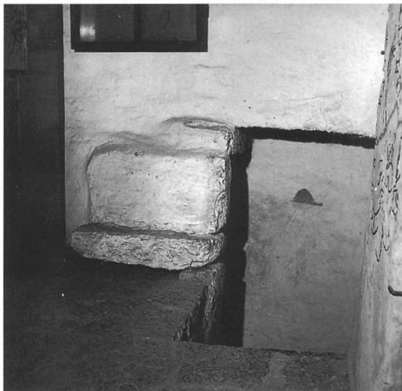
Fig 41. Torntrappans mynning i sydvästra hörnet av tornets första våning. Till vänster rester av en murad skyddshuv. Golvet från 1931. Foto R Boström 1963.
