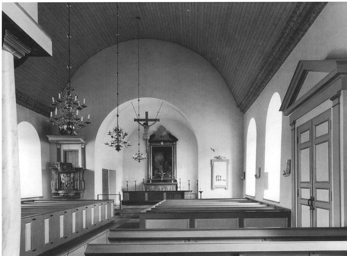
Fig 84. Interiör mot öster efter restaureringen 1966. Arvid Källströms Kristusbild placerad på nytt kors. Jfr fig 82. Foto R Hintze 1982.
