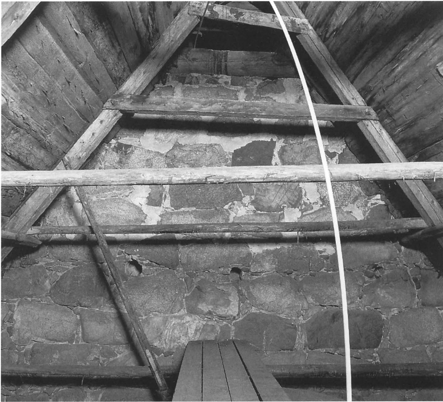
Fig 50. Vapenhuset, långhusets sydmur mot vinden. Foto GH 1996.
