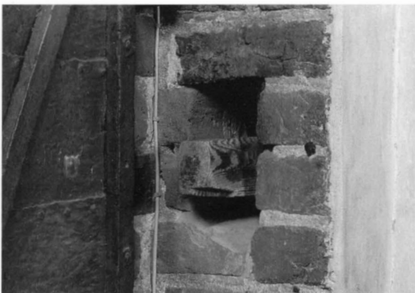
Fig 63. Koret, ingång i söder, ränna i murverket med bom. Foto GH 1996.
