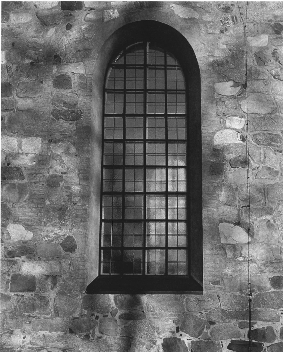
Fig 47 Långhuset, södra muren, omfattning och igenmurning tillhörande tidigare fönster t.v. om nuvarande fönster. Foto GH 1996.
