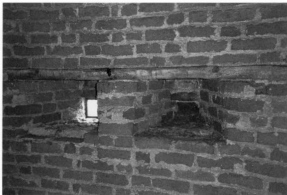
Fig 17. Norra stigluckan, vinden, skyttegluggar i norra muren. Foto förf. 1996.
