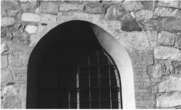
Fig 46. Södra korfönstret, övre delen med murskarv öster om fönstret. Foto förf. 1996.
