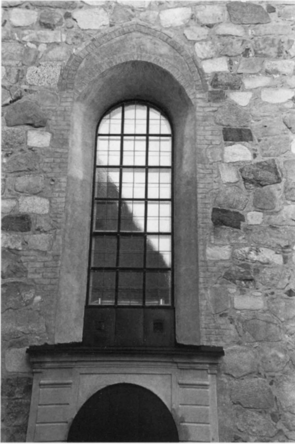
Fig 48. Västfasaden, omfattning och igenmurning tillhörande tidigare fönster ovanför nuvarande fönster. Foto förf. 1996.
