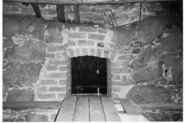
Fig 53. Vapenhuset, södra gaveln, öppning mot vinden (jfr fig 49). Foto förf. 1996.
