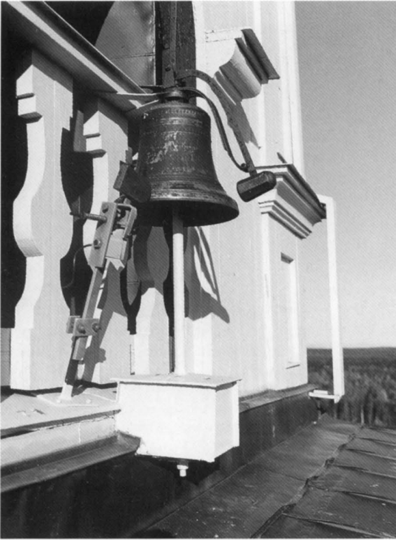
Fig 201. Slagklockan med urspr. hammare av järn och sekundär eldriven hammare, 1800-talets mitt. Foto GH 1997.
