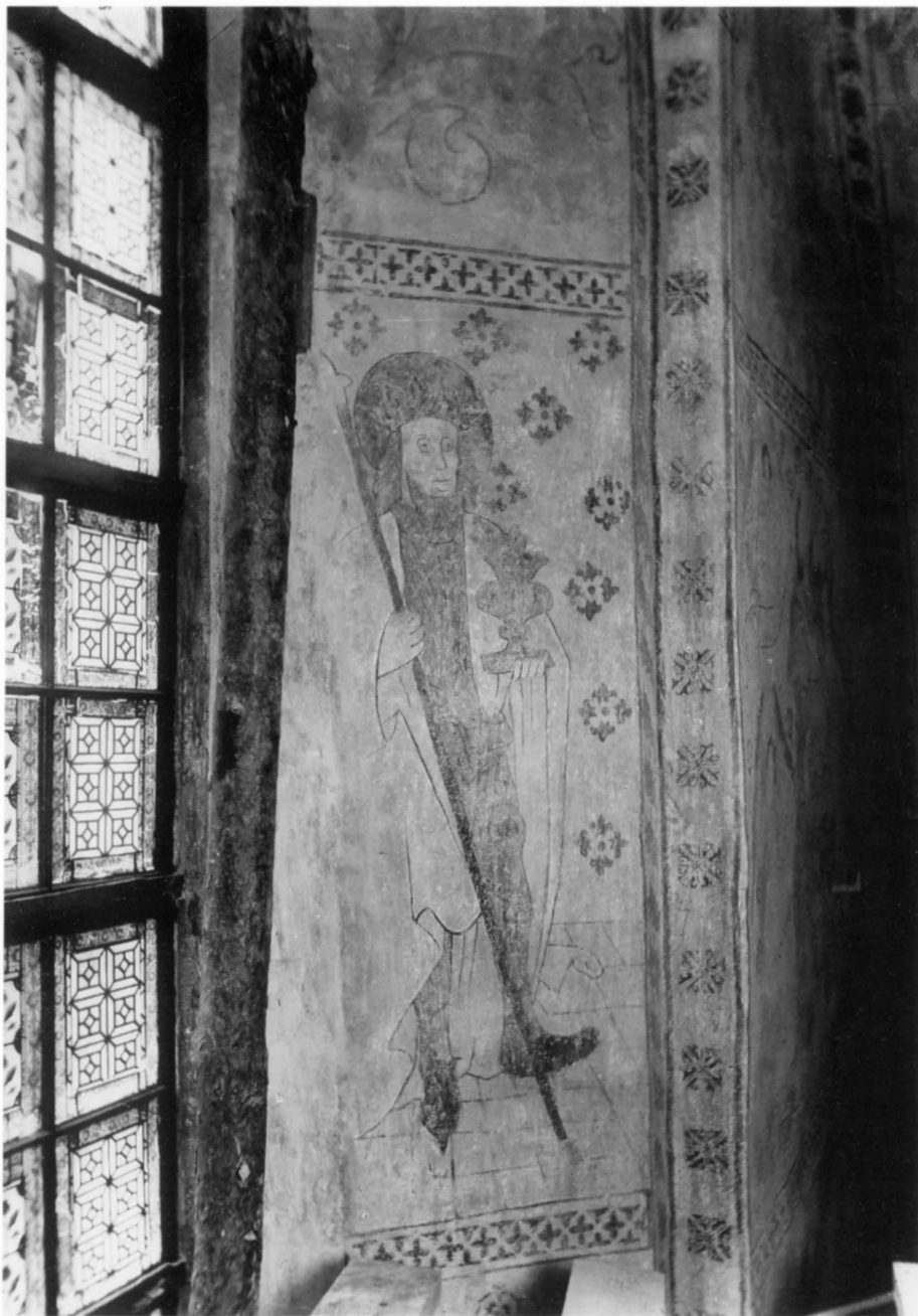
Fig 61. Korfönstret, dekorerat med målat papper. Smygen avfasad vid utvidgning av fönstret. Kalkmålning föreställande Sankt Olof. Foto C Lundin 1909. ATA.
