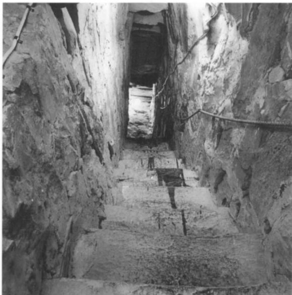
Fig. 18. Trappan i tornets södra vägg. Foto 1995.
