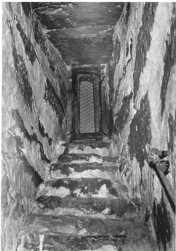
Fig. 47. Ljusöppning med nedtill avtrappad smyg i tornets västra mur. Foto 1997.
