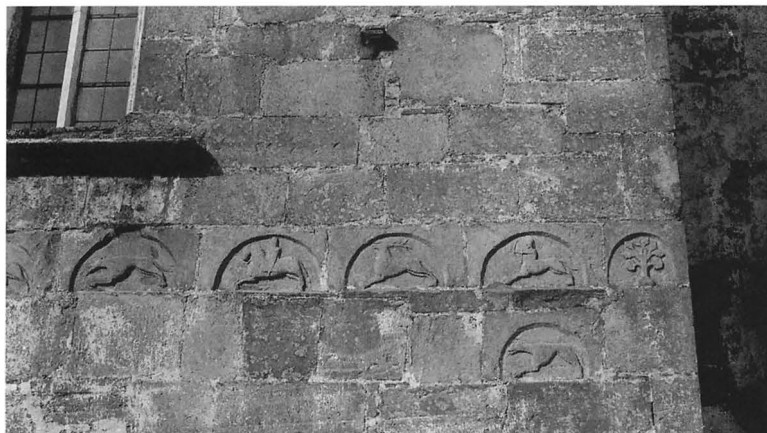
Fig. 43. Detalj av södra långhusmuren med inmurade romanska reliefstenar (nr 40–44, 46). Ovanför inmurad konsol från en reliefsten. Foto I. Swartling 1970. ATA.
