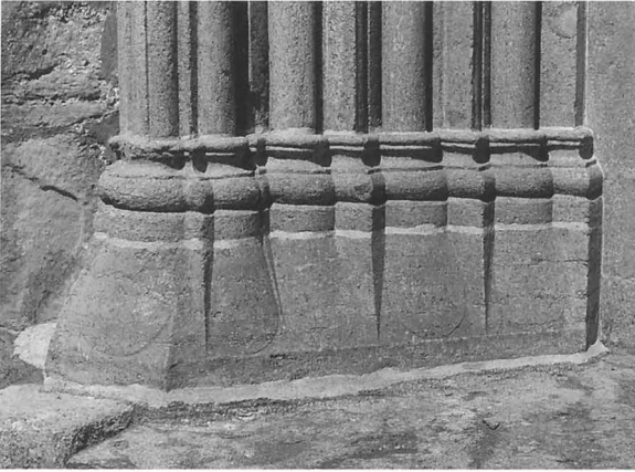
Fig. 25. Långhusportalens västra basband. Foto 1997. The west base band of the nave doorway.
