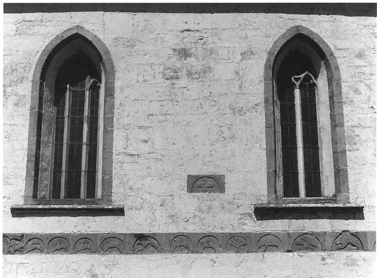
Fig. 42. Detalj av långhusets södra mur med inmurade romanska reliefstenar (nr 30–40, 45). Foto 1997.
