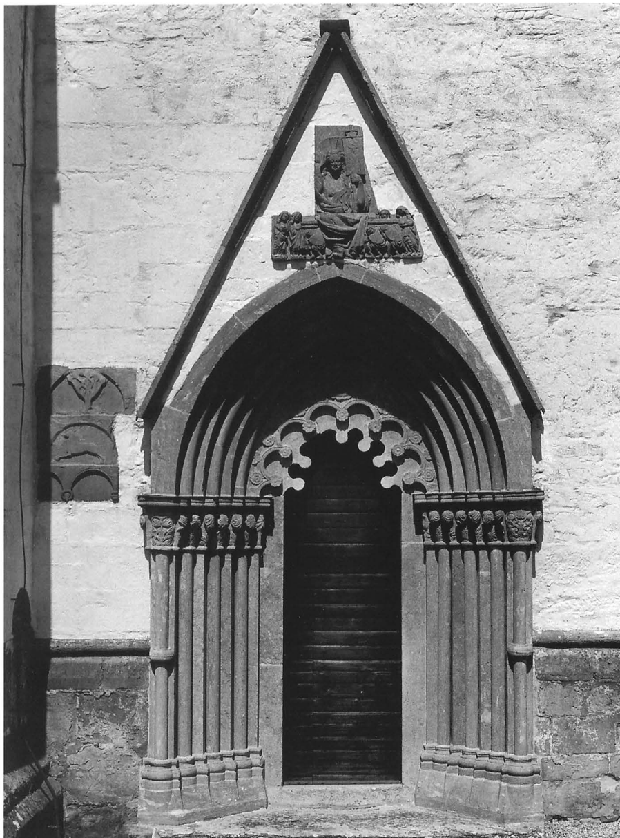
Fig. 33. Korportalen. Foto 1997. The chancel doorway.
