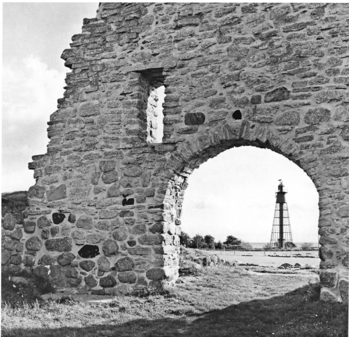
Fig 35. Långhusets och korets inre mot nordöst. I bakgrunden Kapelluddens fyr. Foto R Hintze 1980.
